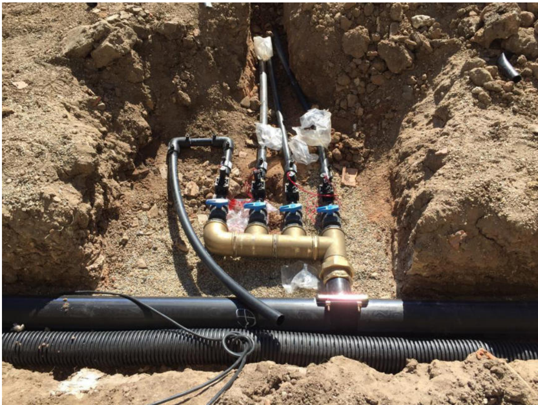
Imagen 11. Instalación de electroválvulas.
