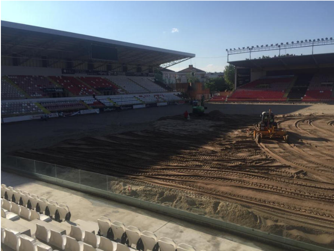
Imagen 8. Nivelación láser de terreno de juego.
