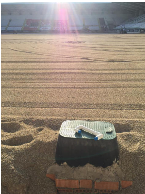
Imagen 10. Arqueta de PVC inyectado rectangular para alojamiento de electroválvulas
