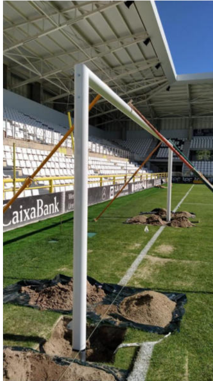
Imagen 5. Detalle instalación de portería de fútbol 11.
