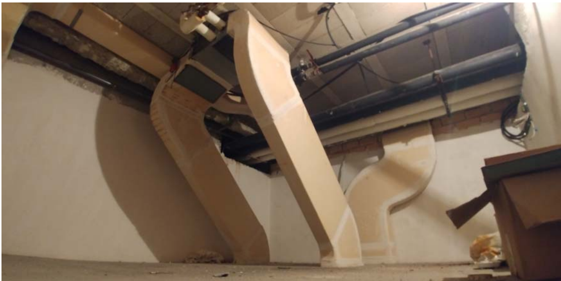
Techos. Espacio de falsos techos, con instalaciones existentes.
