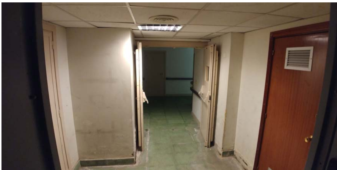
Area de acceso. Espacio de acceso desde el pasillo de servicio del sótano del Pabellón A.
