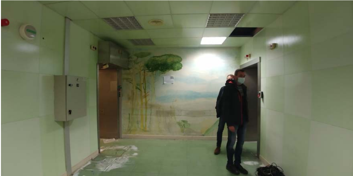
Distribuidor interior. Espacio interior en el ámbito bajo, con acceso a salas del antiguo acelerador y bomba de cobalto.
