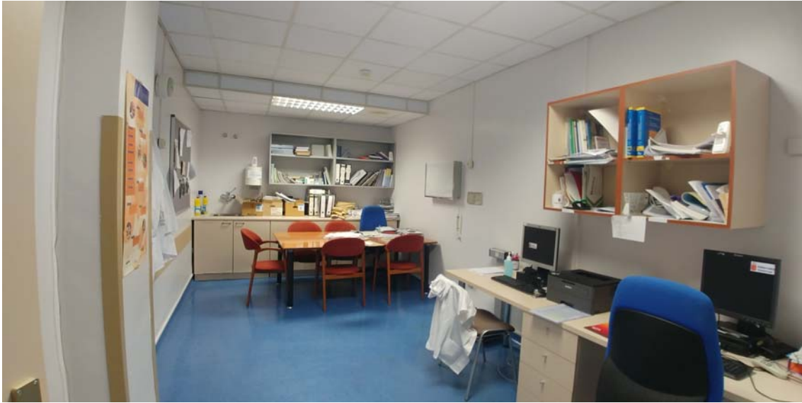
Despacho. Espacio que formará parte de la nueva sala para la Gammacámara.
