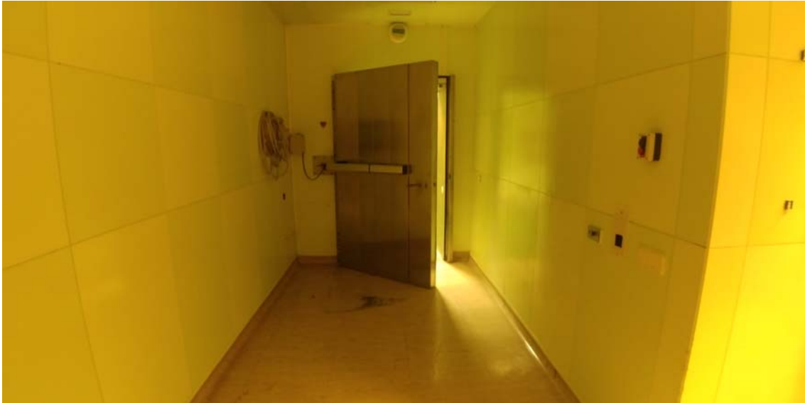
Sala antigua Bomba de Cobalto. Espacio previsto para ubicación de nuevos boxes.
