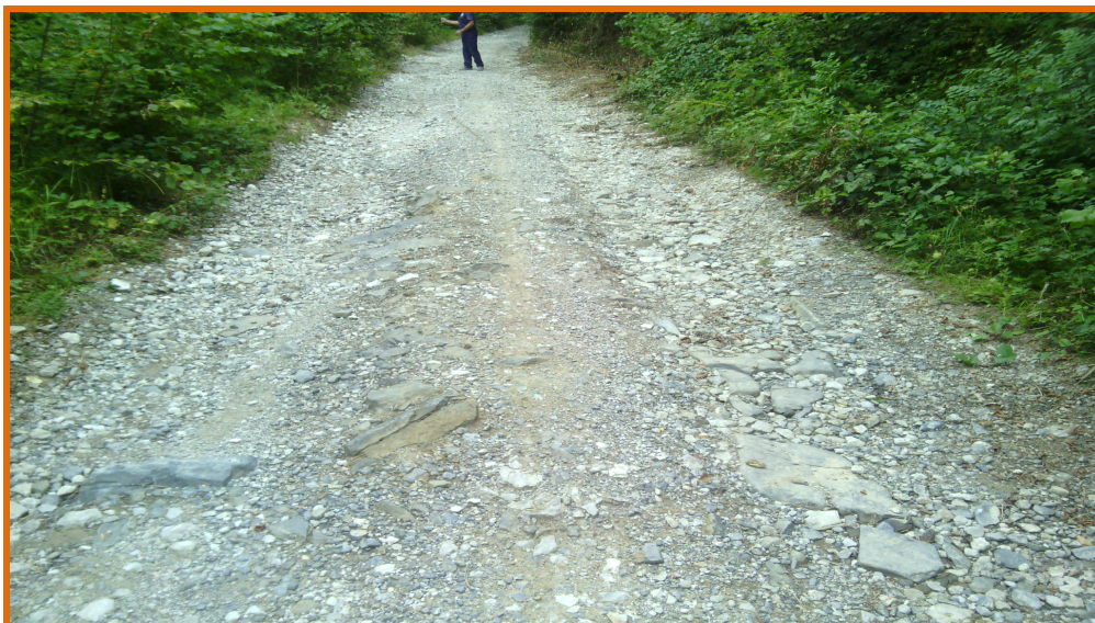
Foto 1. Detalle del tramo de vial de La Sarria objeto de perfilado y construcción de solera de hormigón.
