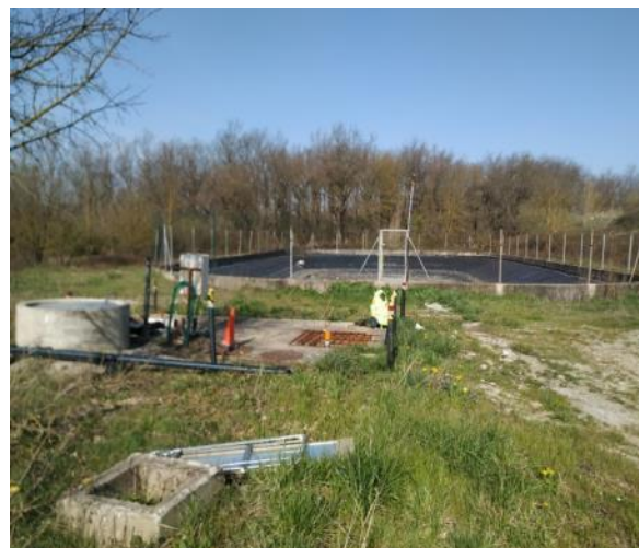
Fotografía 3. Vallado perimetral existente.
