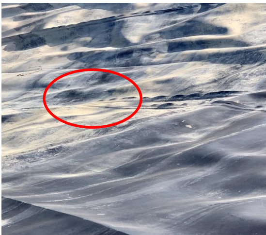
Fotografía 6. Punto triple sin extrusión.
