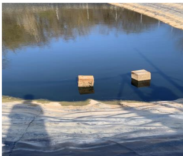
Fotografía 2. Obra de salida-Punto de desagüe.
