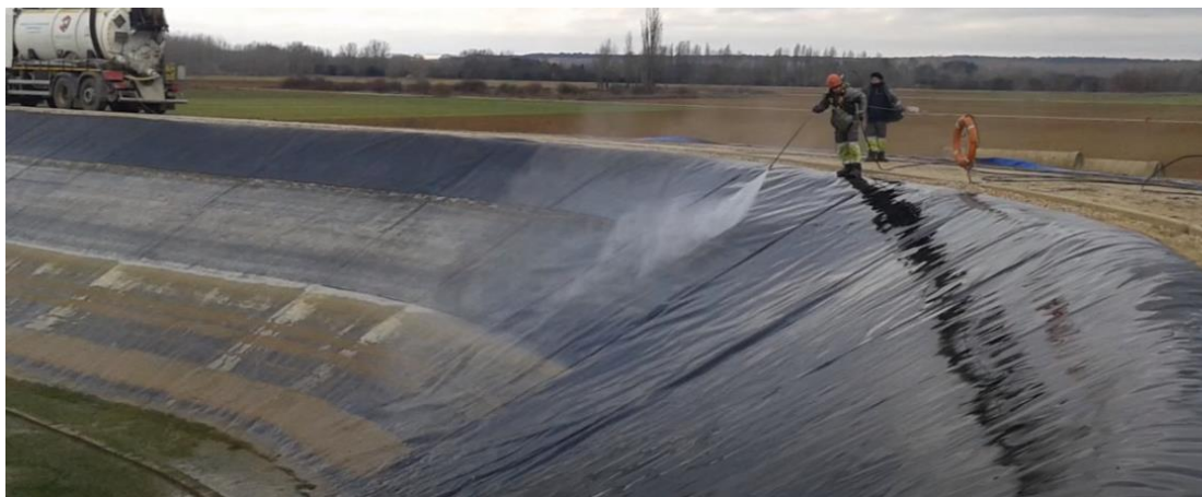
Fotografía 2. Limpieza de los taludes con agua a presión.
