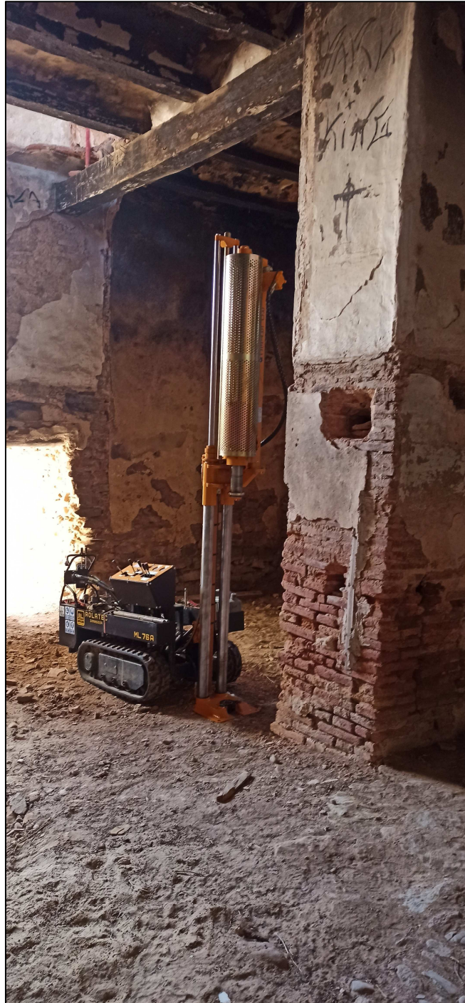
Detalle del emplazamiento del ensayo de penetración dinámica
