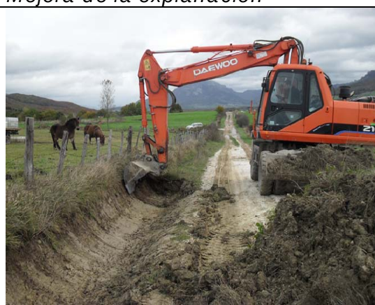
Limpieza de cunetas
