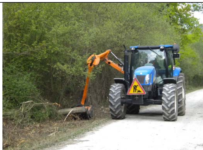
Desbroce de márgenes
