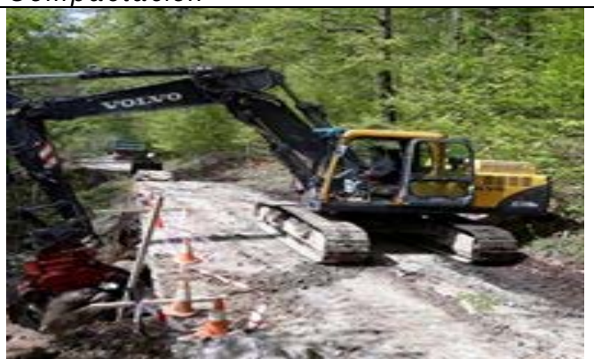
Construcción de escollera
