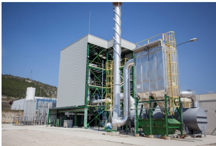
Figura 1. Planta de gasificación de 2 MWt con tecnología de lecho fluidizado burbujeante
