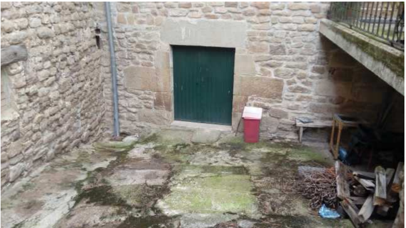
Foto 4: Pavimentación de acceso al semisótano.
