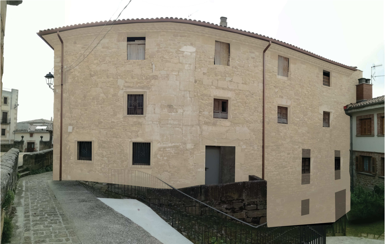
Foto-montaje aspecto de la fachada Noroeste después de la intervención
