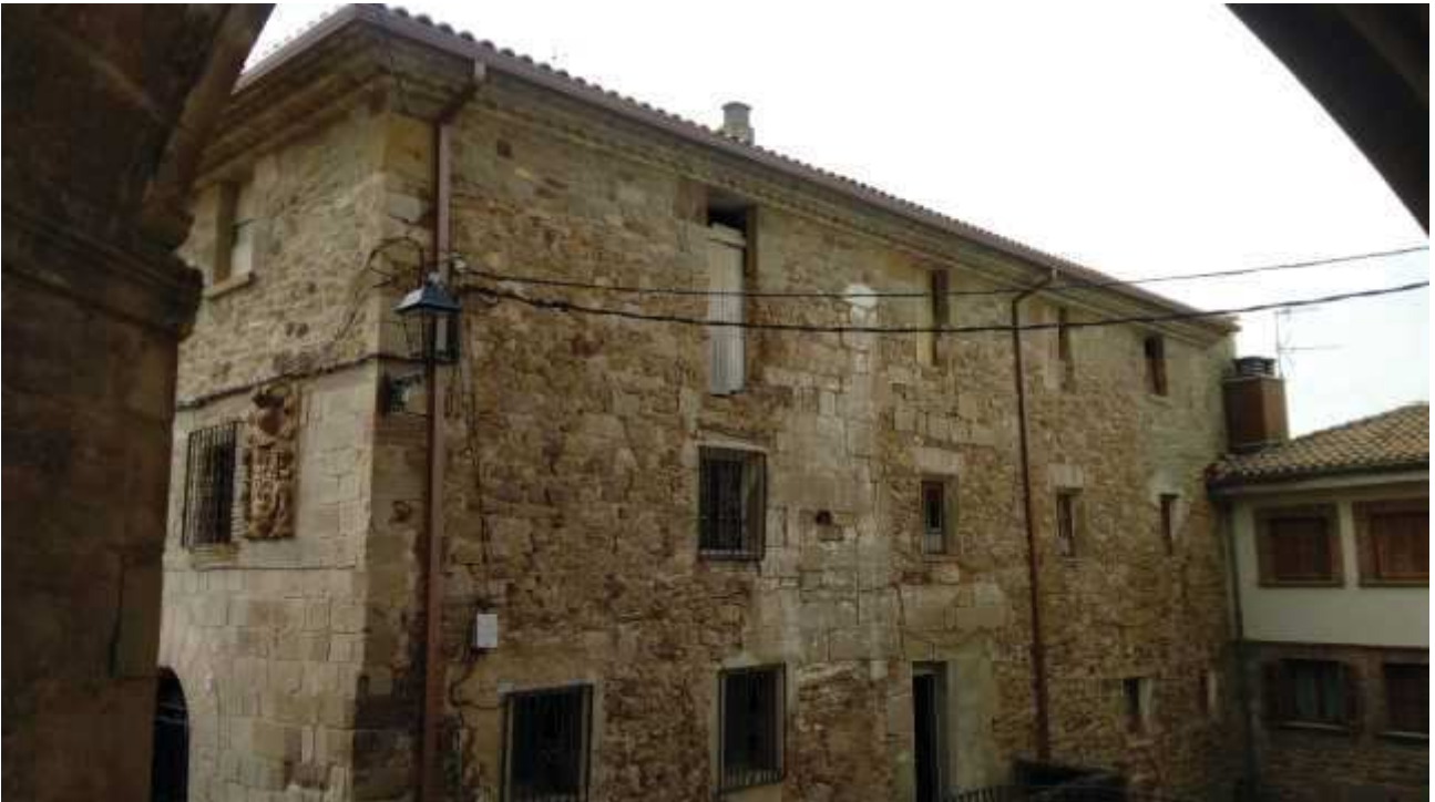
Foto 1: Estado de la Fachada Noroeste
