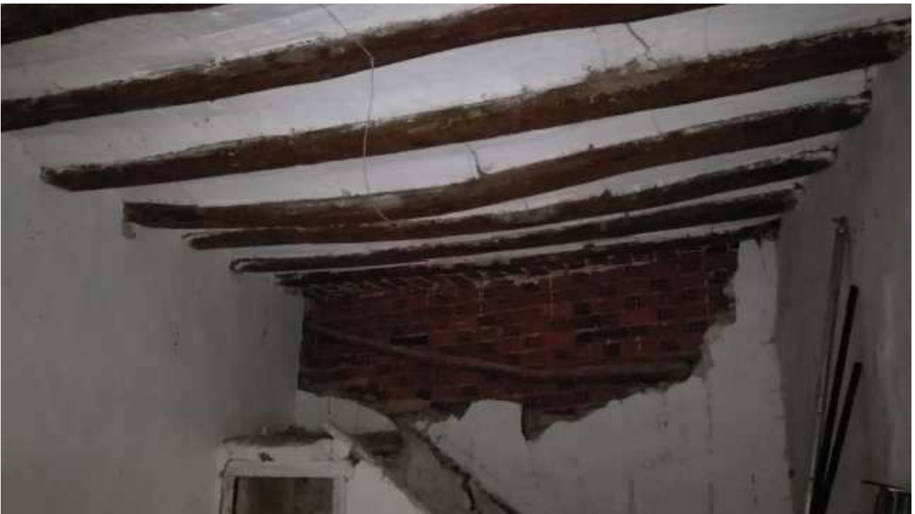
Foto 2: Forjado techo planta baja.
