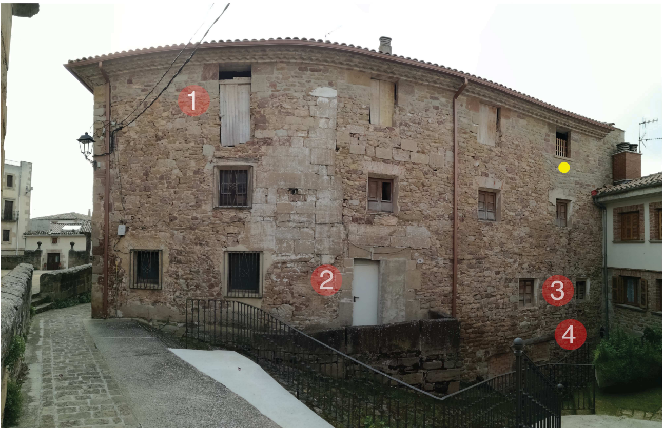
Foto estado actual fachada Noroeste
