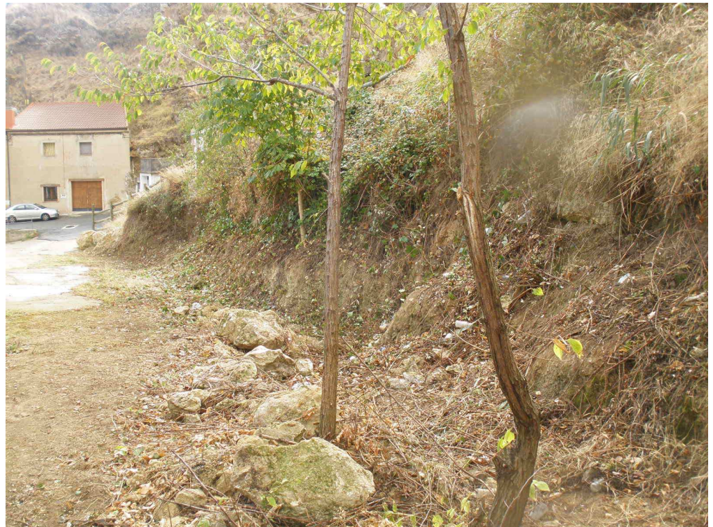
FOTO 6: Vista del tramo de barranco tomada desde aguas arriba tras el desbroce practicado.
