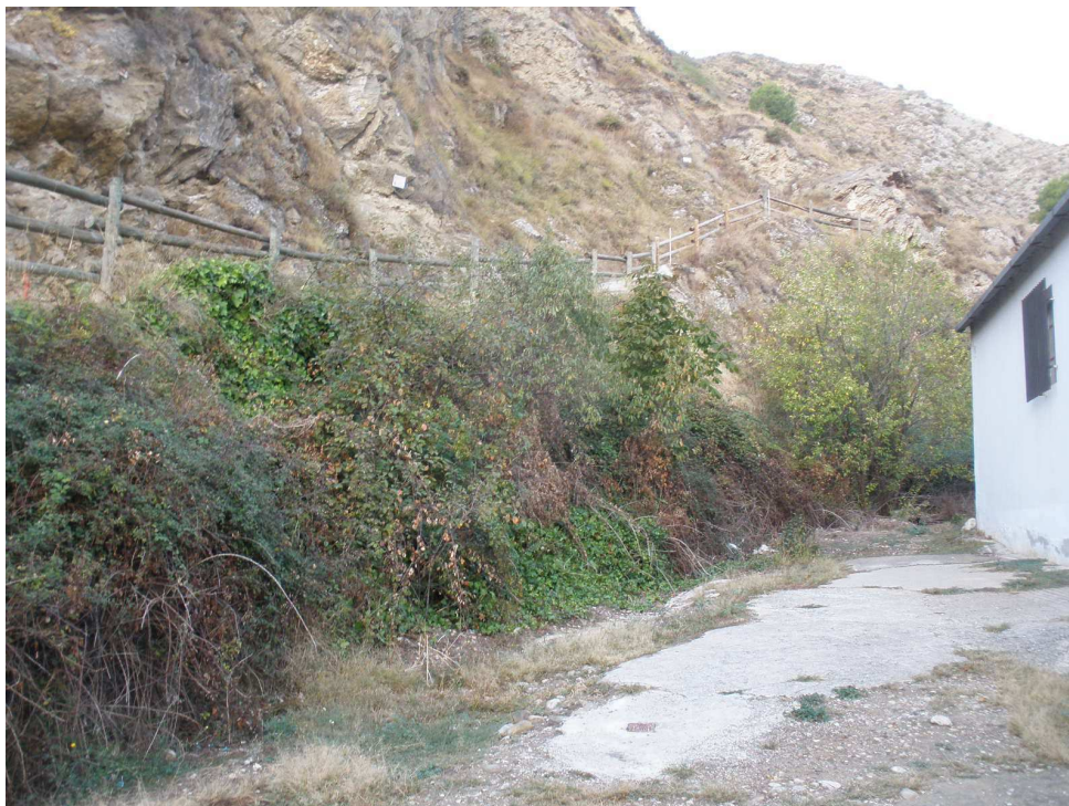
FOTO 1: Vista general del estado que presentaba el talud al inicio de los trabajos. Como puede verse, se encontraba completamente recubierto de una vegetación que impedía la visualización del talud propiamente dicho.
