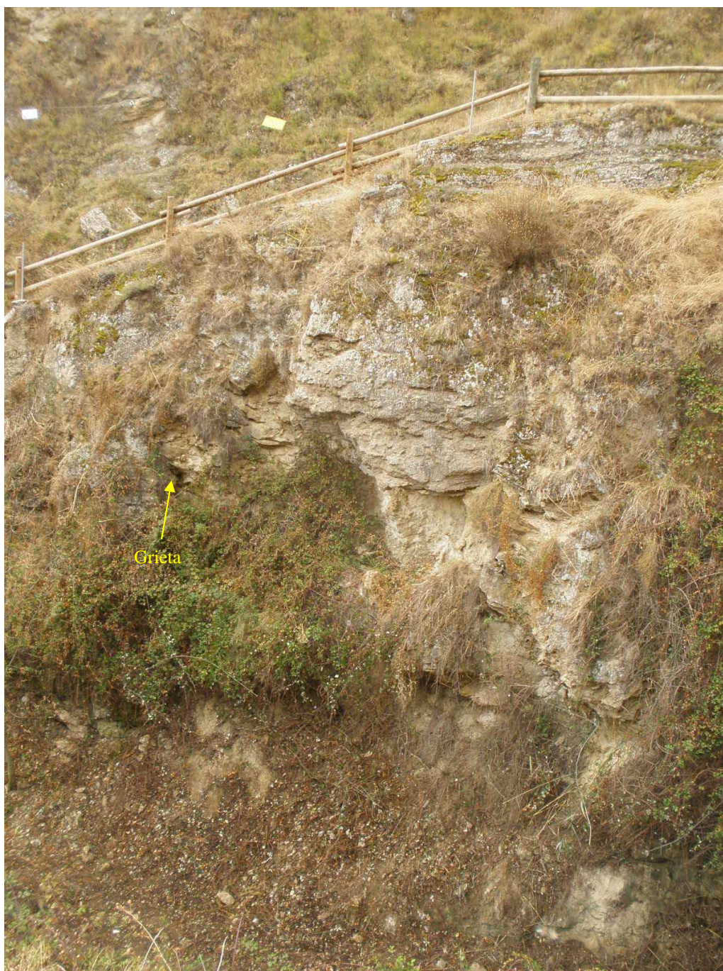
FOTO 13: En la fotografía se señala la presencia de la fractura en el macizo rocoso.
