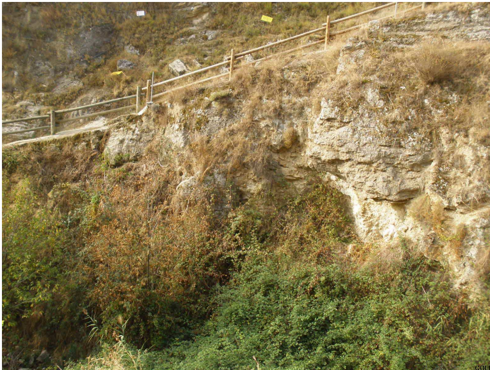
FOTO 18: Estado que presentaba la zona antes del desbroce de la vegetación (zarzal).
