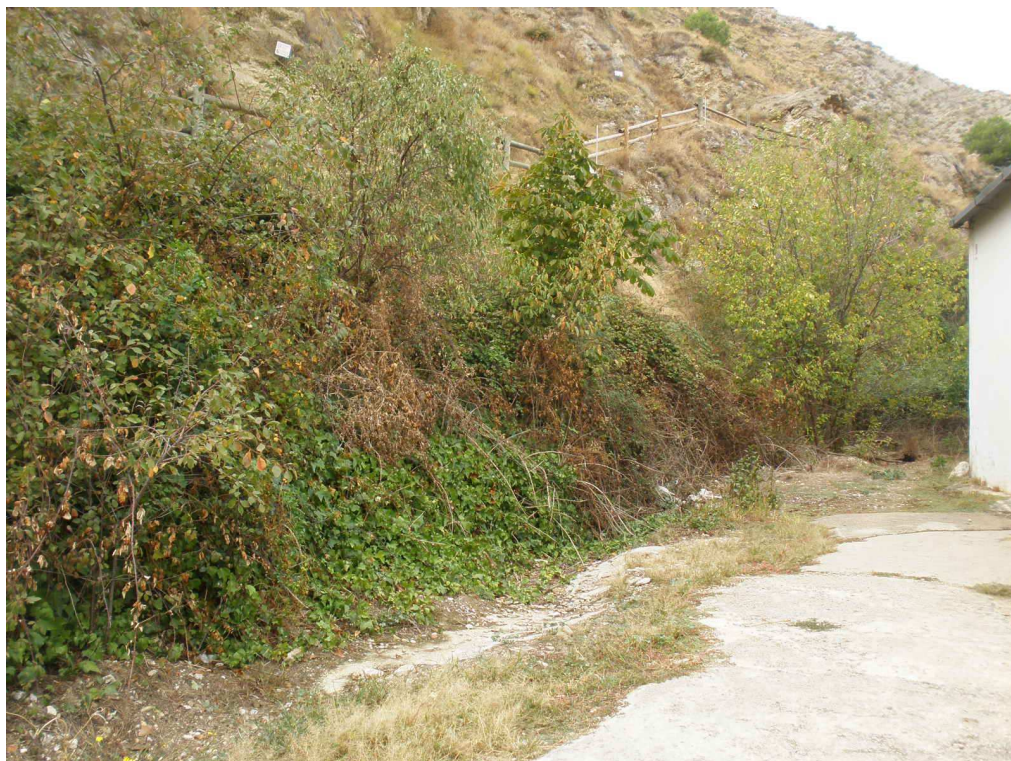
FOTO 5: El cauce del barranco, tras sobrepasar la primera edificación situada en su margen izquierda, queda reducido a una pequeña cuneta en tierras situada a pie de talud.
