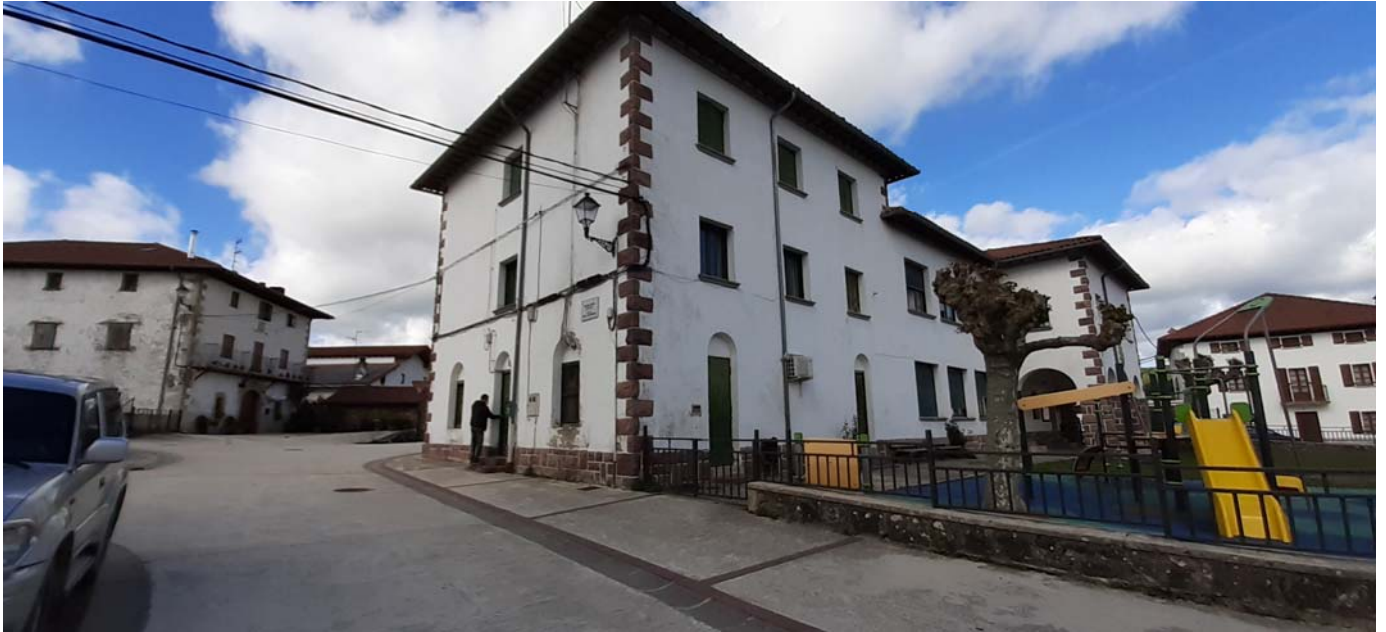
Fachadas Oeste y Sur del edificio
