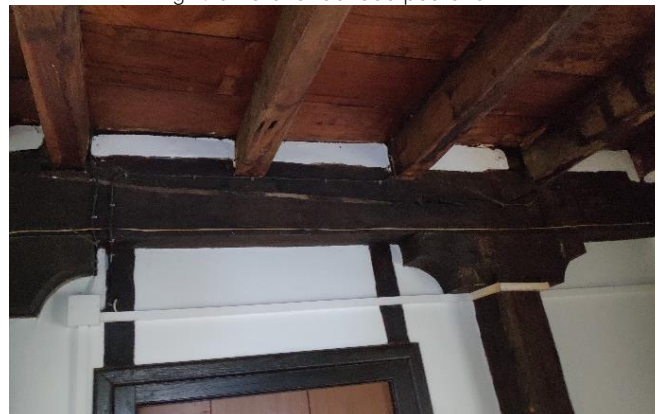
Fig 2.12 Estructura interior de madera
