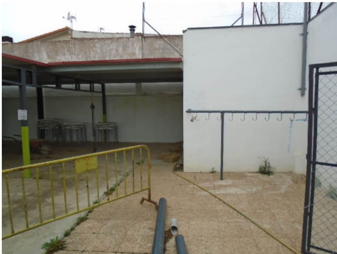
EXTERIOR CASETA DE INSTALACIONES
