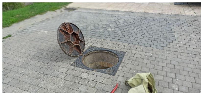
FOTO 7: Vista pozo de registro de saneamiento (altura aproximada 3,50 m).
