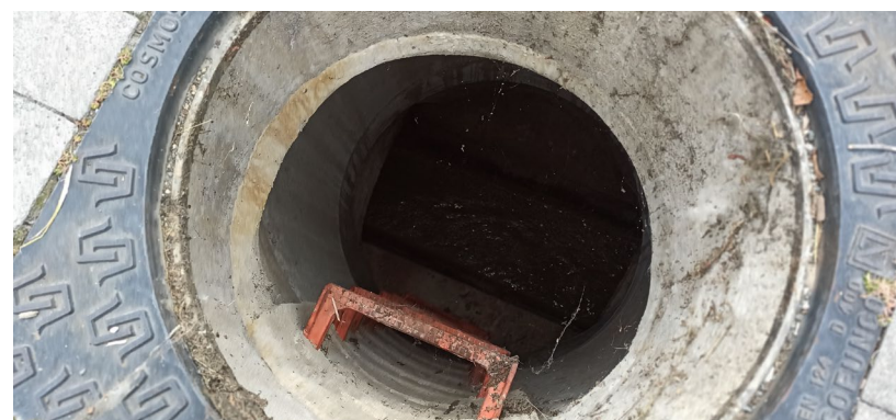
FOTO 8: Vista pozo de registro de saneamiento (altura aproximada 3,50 m).
