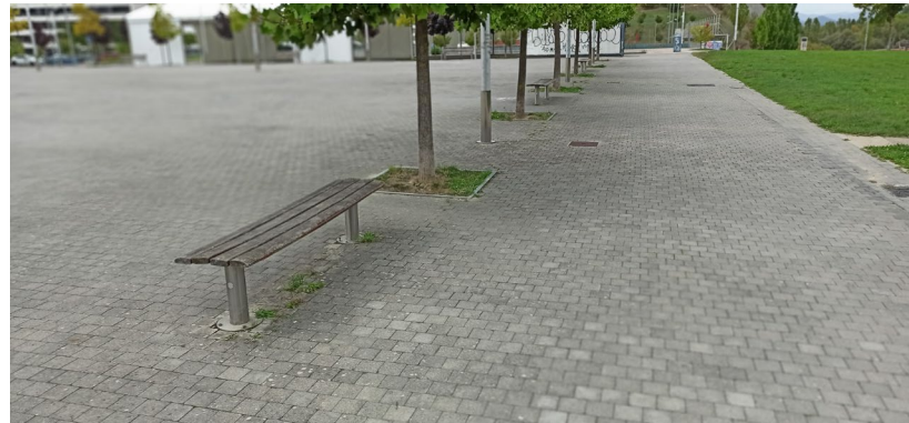
FOTO 11: Vista hacia posible conexión arqueta eléctrica.
