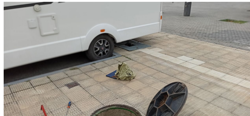
FOTO 5: Vista pozo de registro de abastecimiento.
