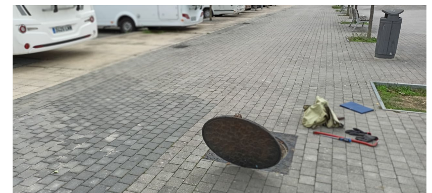
FOTO 9: Vista pozo de registro de saneamiento (altura aproximada 3,50 m).
