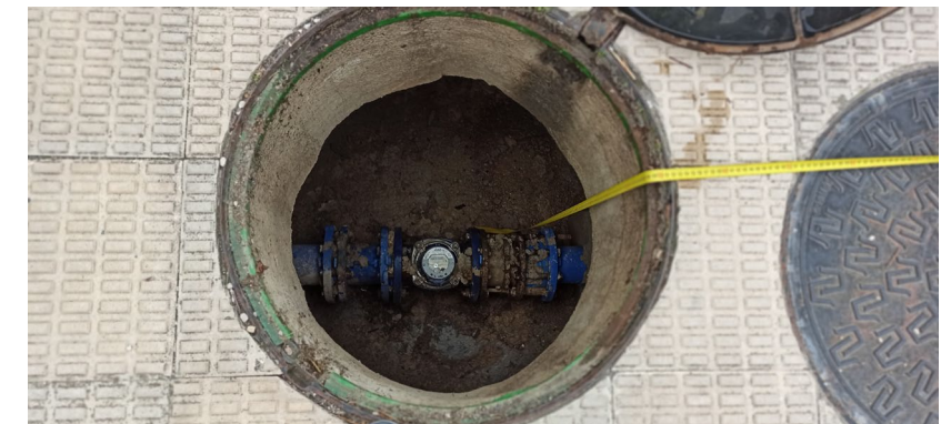
FOTO 6: Vista pozo de registro de abastecimiento (altura aproximada 1,20 m).
