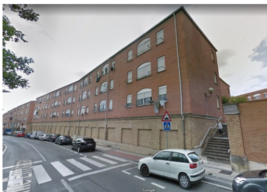
Imagen de bloques con tipología Planta Baja (sin uso) + 3 (viviendas)
