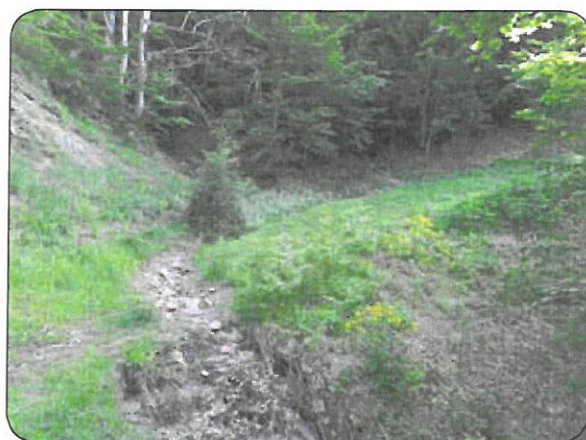
Caudales atravesando la calzada
