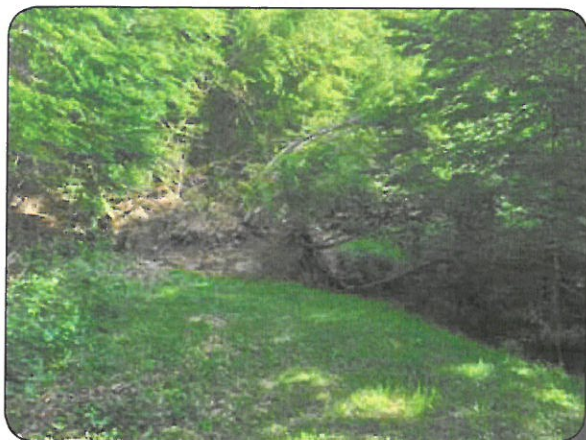
Desprendimiento sobre la calzada
