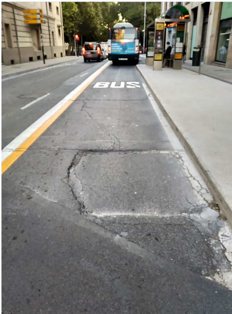
Parada de Bus cercana al cruce con calle Amaya
