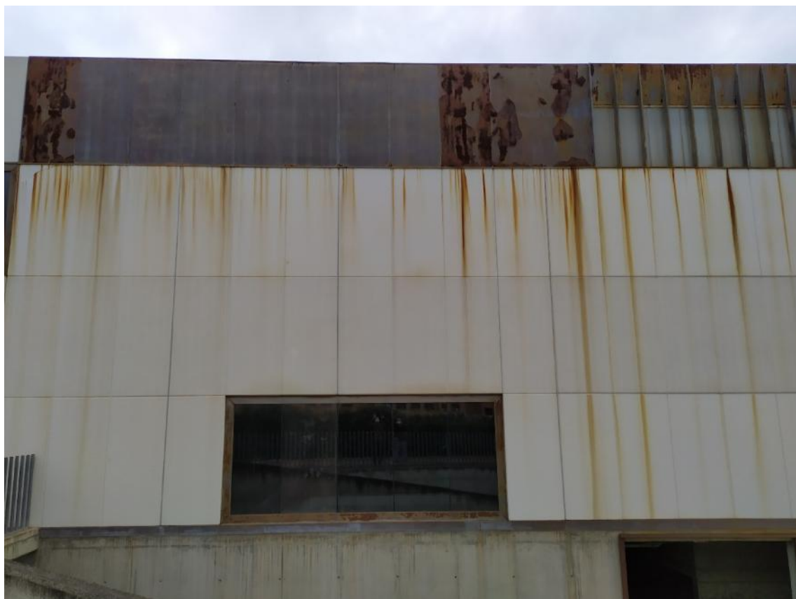
Estado de fachada suroeste
