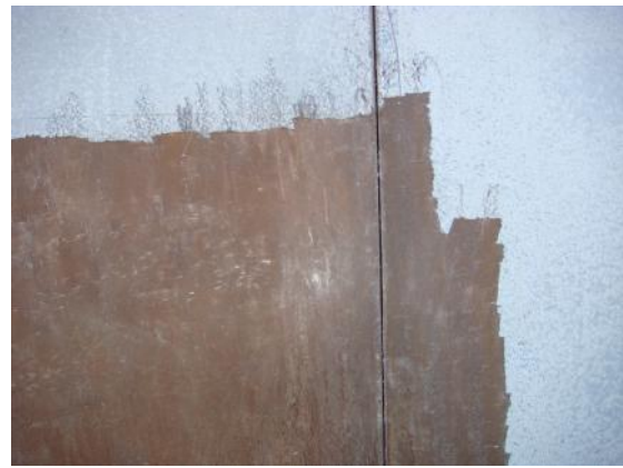
Aspecto final del acero corten lijado
