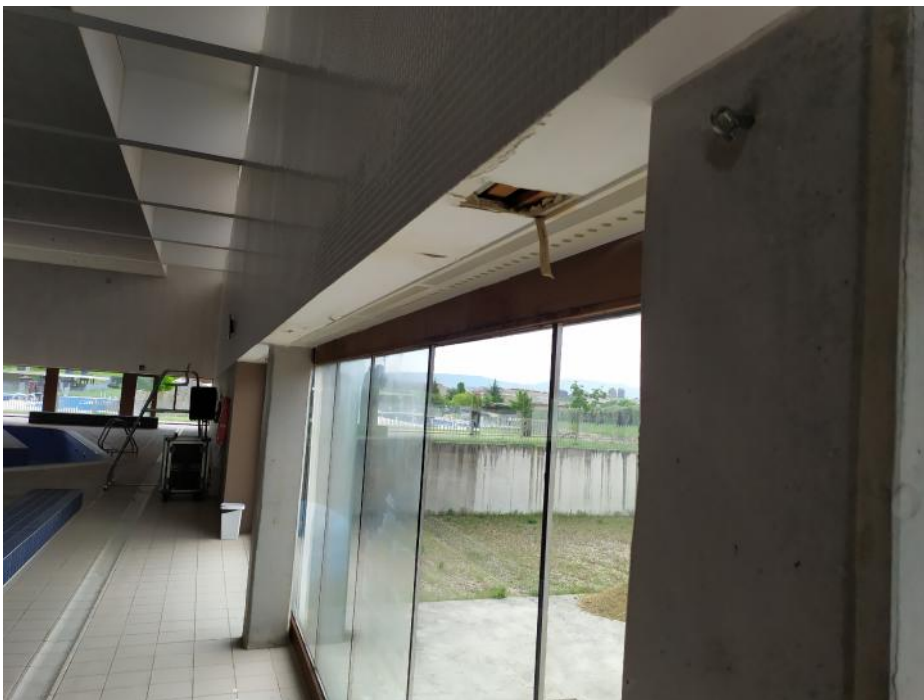
SUSTITUCIÓN DE VIDRIO DOBLE
