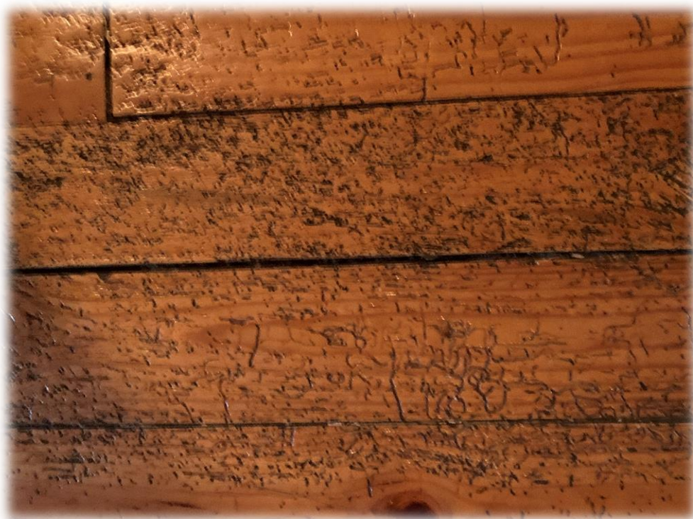
Fotografía 4 – Tarima de la planta primera atacada por xilófagos a renovar.
