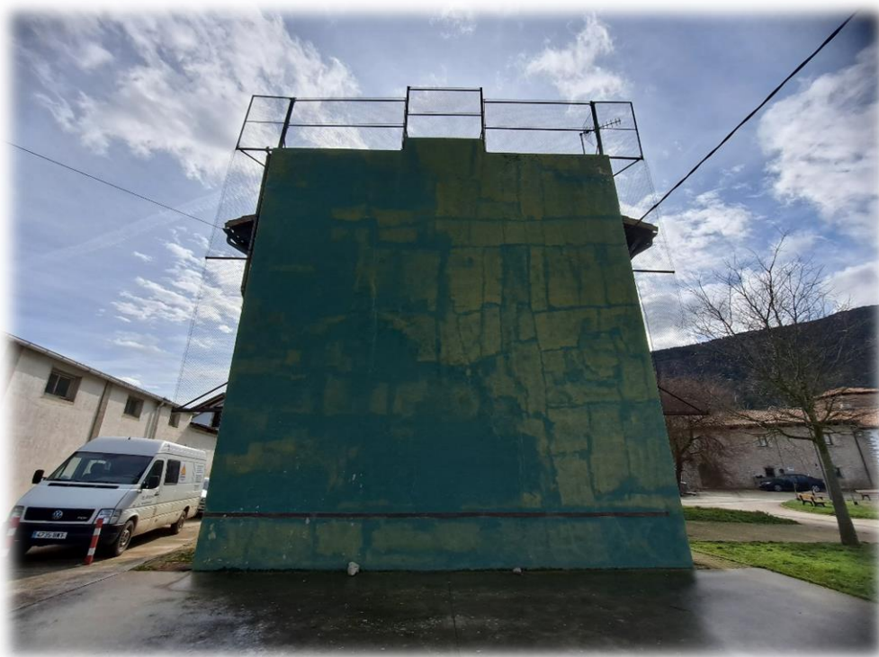
Fotografía 8 –Lateral de la casa concejil, con pintura y escás deteriorados.
