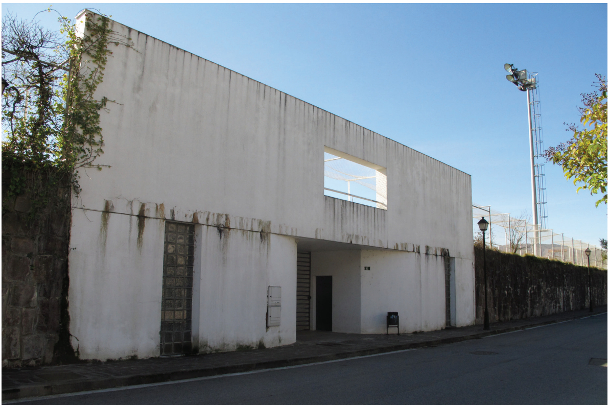
Acceso Norte_Estado actual.
