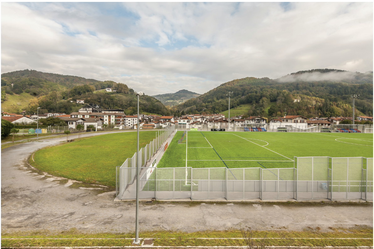
Vista 01_Estado actual.
