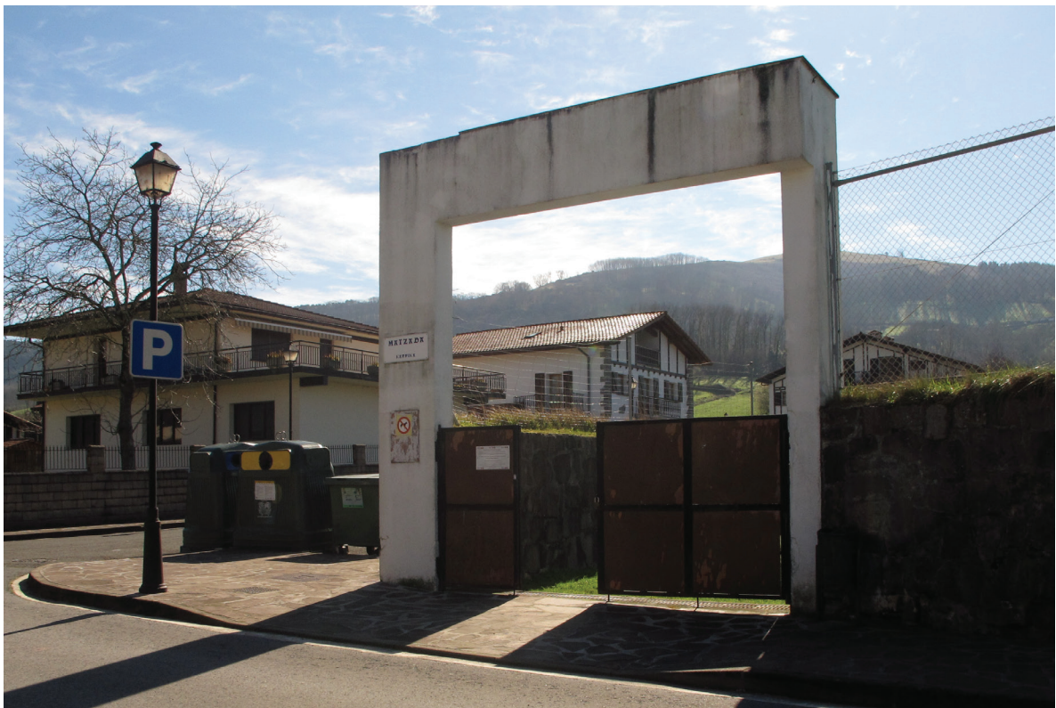
Acceso Noreste_Estado actual.
