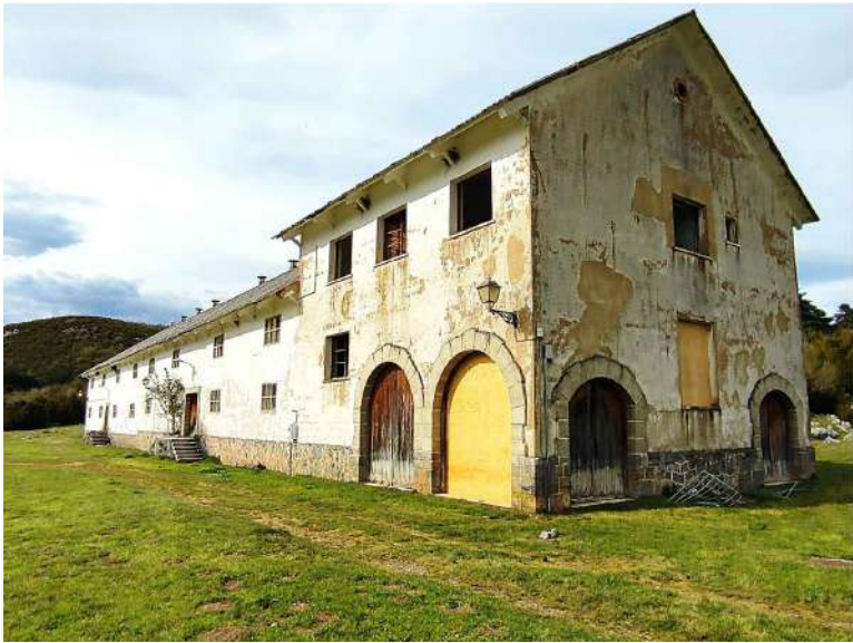
FACHADA SUROESTE y SURESTE
