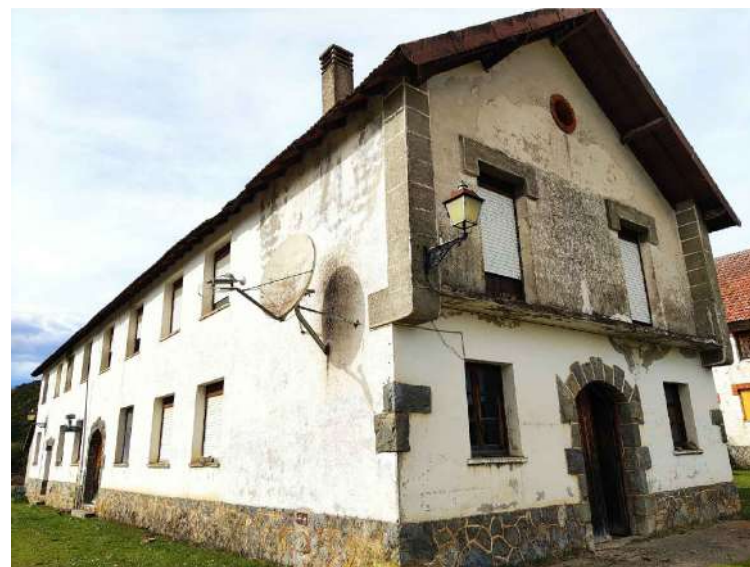
FACHADA SURESTE Y SUROESTE
