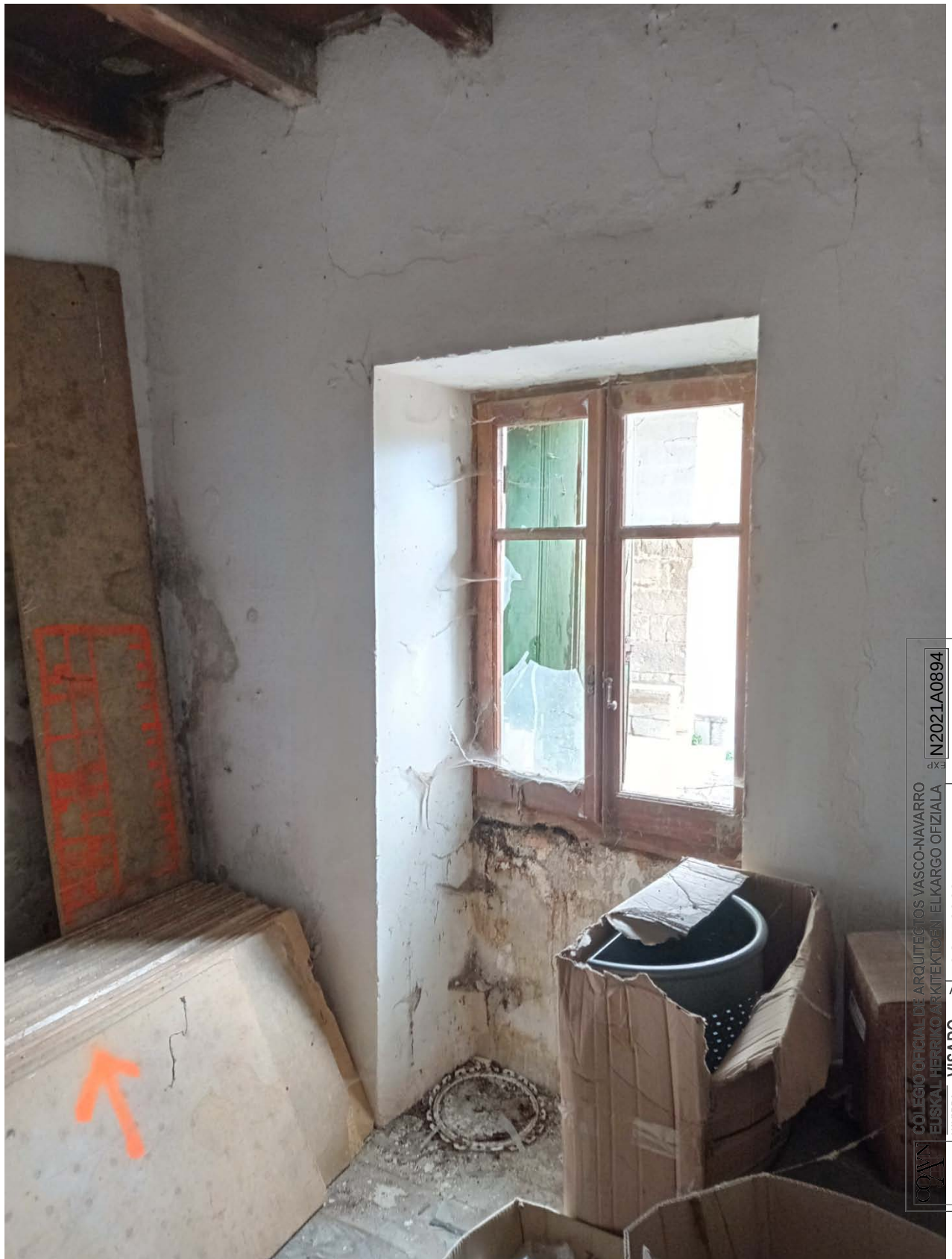
CAPINTERIA EXTERIOR VENTANAS
