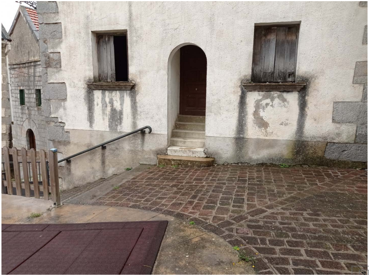
ENTRADA EXTERIOR A PLANTA PRIMERA
