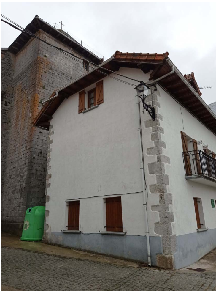
FACHADA NORTE. EDIFICIO CONSULTORIO+VIVIENDA
