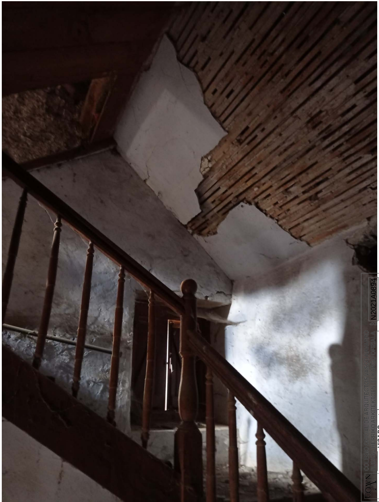
ACCESO A PLANTA TERCERA. BAJO CUBIERTA
