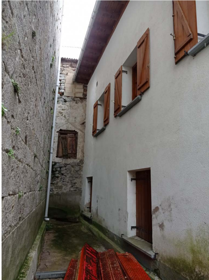
CALLEJÓN ENTRE EDIFICIO CONSULTORIO+VIVIENDA E IGLESIA
