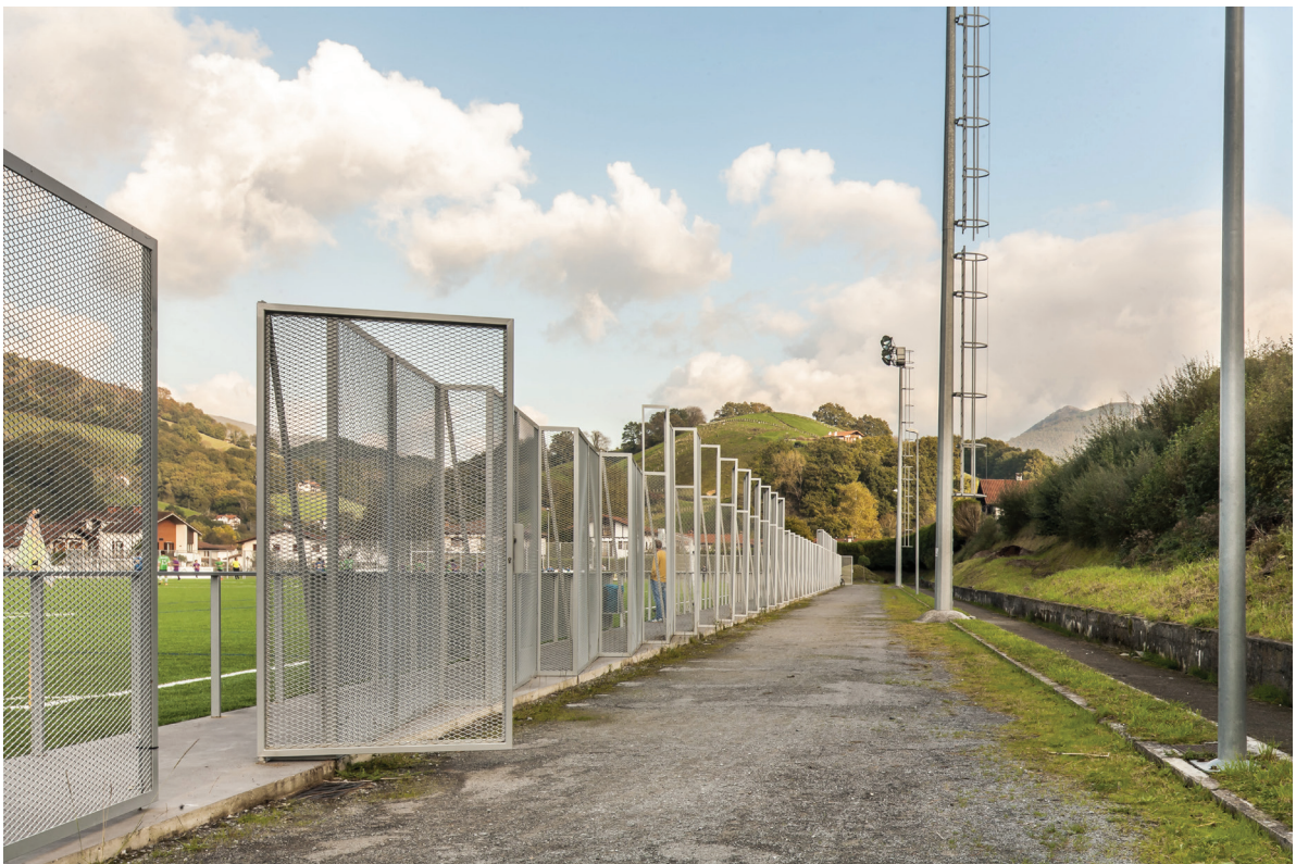
Vista 03_Estado actual.
