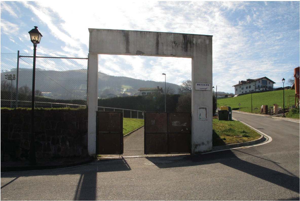
Acceso Noroeste_Estado actual.
