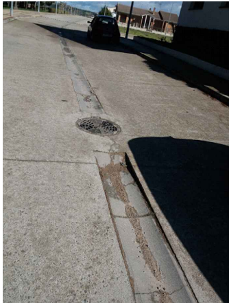
F1 ASENTAMIENTO Y ROTURA DE CAZ
