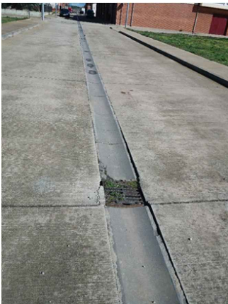
F2 ASENTAMIENTO DE REJILLA DE PLUVIALES Y CAZ PREFABRICADO
