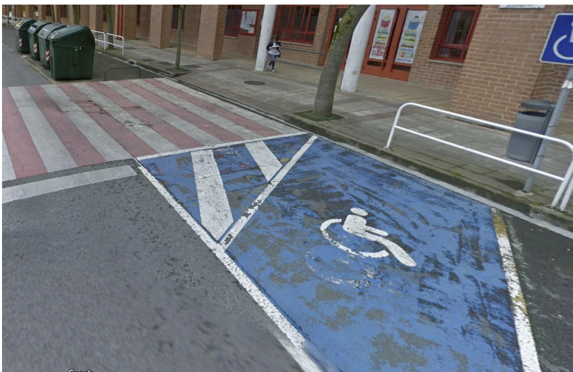
FOTOGRAFÍA 14. PASO PEATONES AVDA. EULZA
