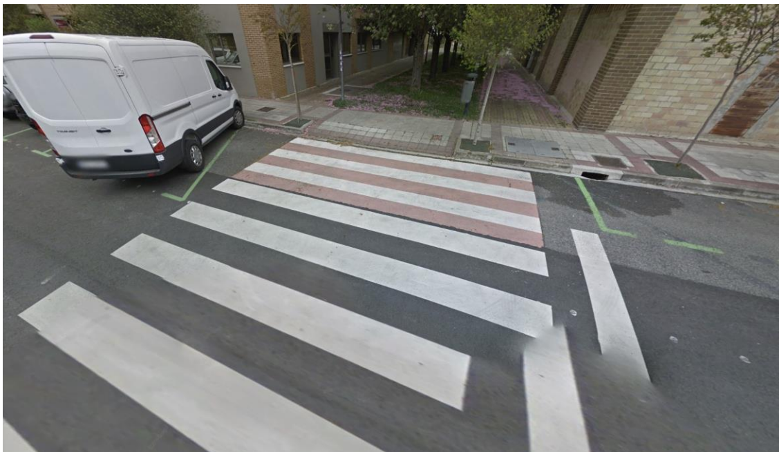
FOTOGRAFÍA 11. PASO PEATONES AVDA. EULZA
