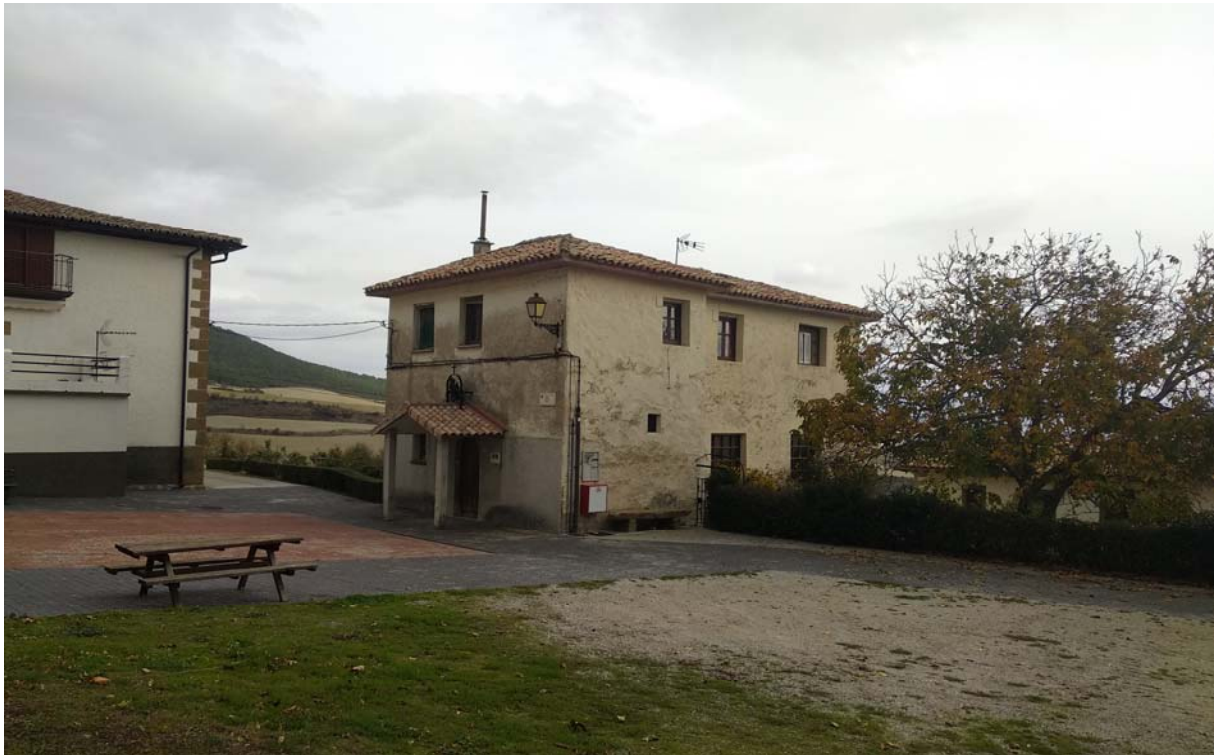
1. Entorno y entrada Edificio, fachada sur y oeste
