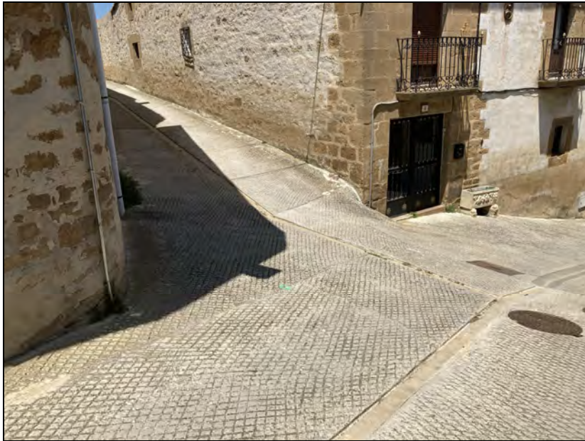
Encuentro con la calle Guiriria, desde el sur. Pavimentos de hormigón con un caz central realizado con pieza cerámica.
