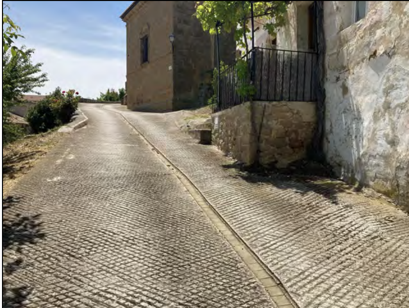
Punto singular, formado por una plataforma de acceso a unas edificaciones.
