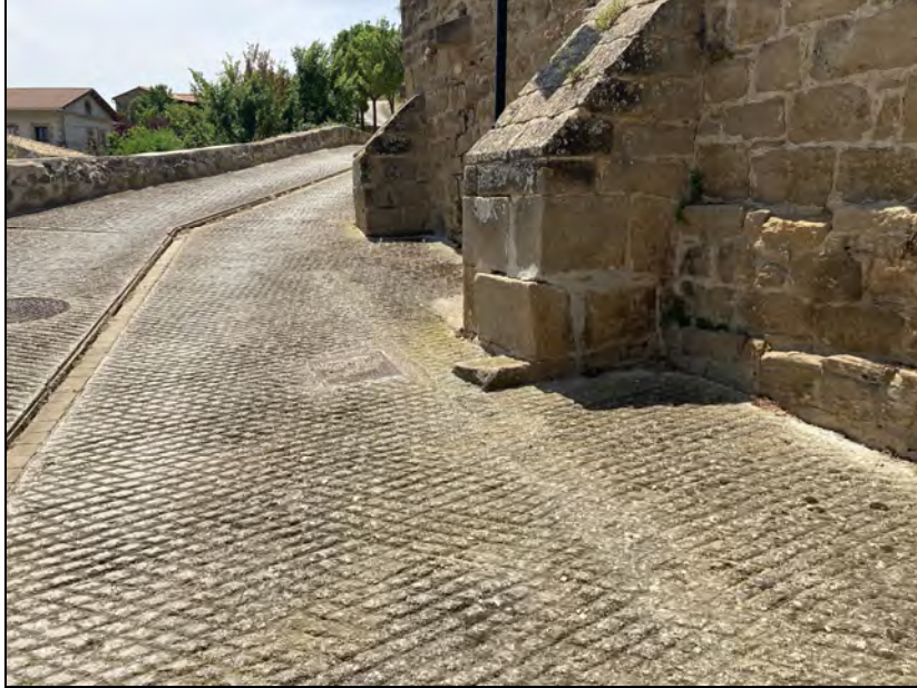
Muro y contrafuertes del atrio de la iglesia.
