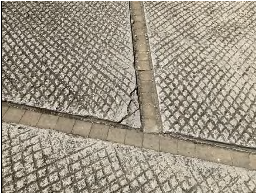
Canaleta de recogida de pluviales con pieza cerámica.
