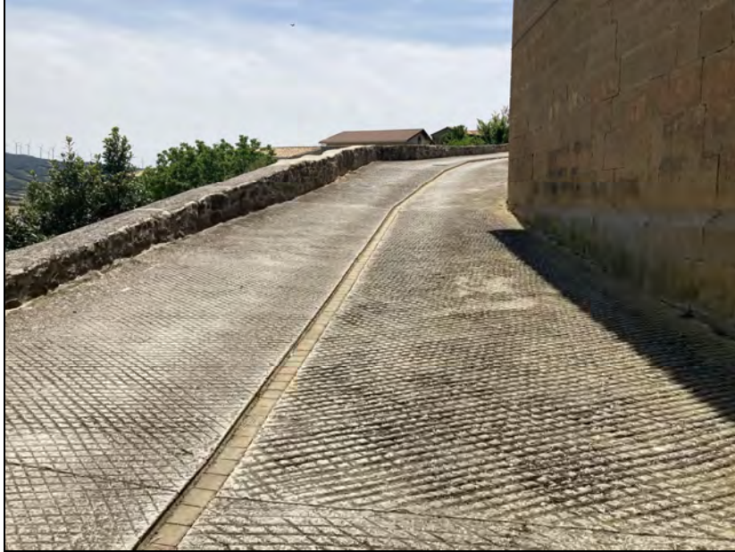
Zona superior de la calle, que rodea el atrio de la iglesia, delimitada por un importante muro de contención hacia el sudeste.
