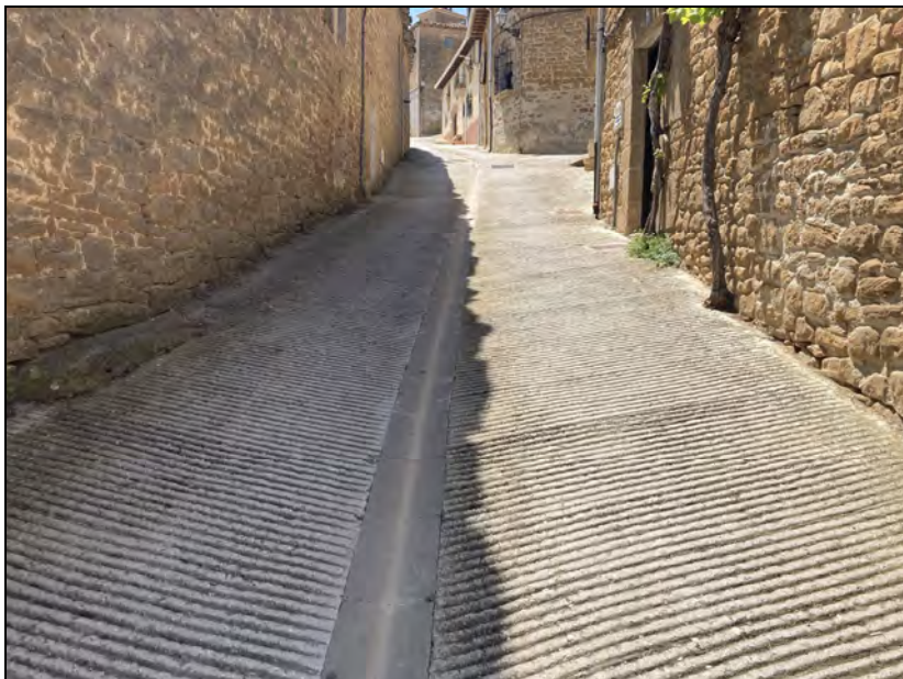
Caz de hormigón prefabricado.
