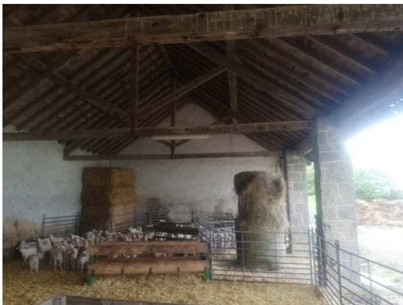
Interior nave ganadera 2
