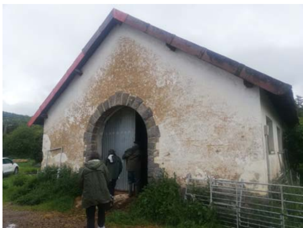
Alzado suroeste – Acceso a nave ganadera 3
