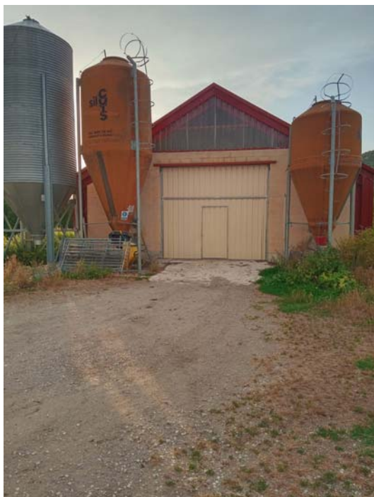
Alzado sureste – Acceso a nave ganadera 1
