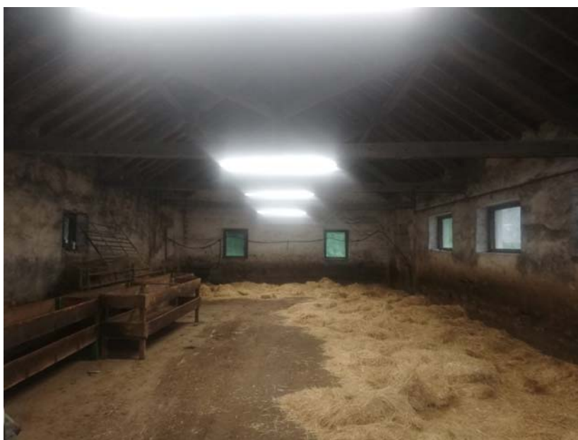
Interior nave ganadera 3
