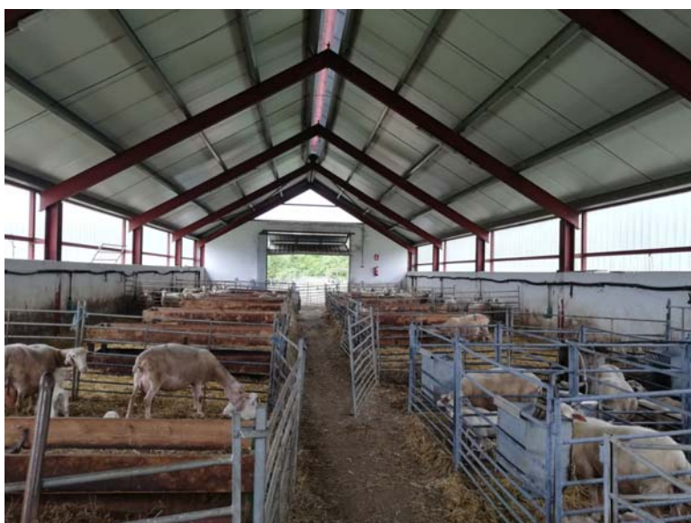
Interior Nave ganadera 1
