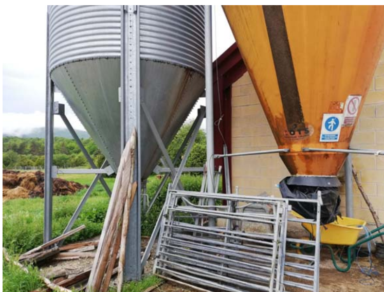
Silo metálico a sustituir
