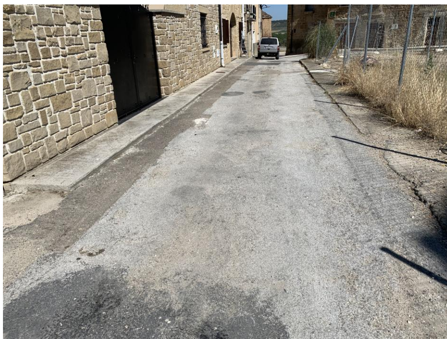
Estado actual Calle Norte
