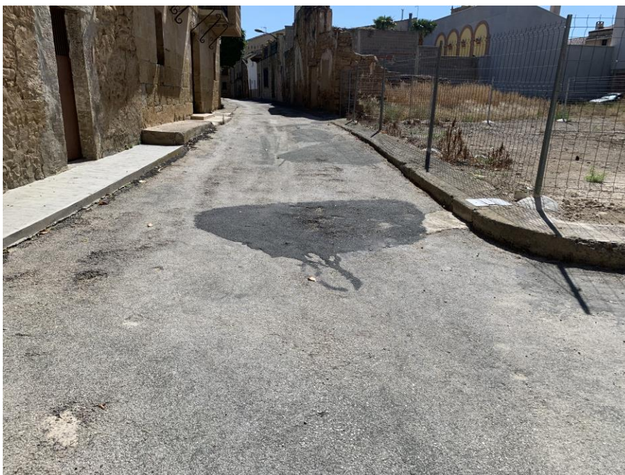
Estado actual Calle Mayor
