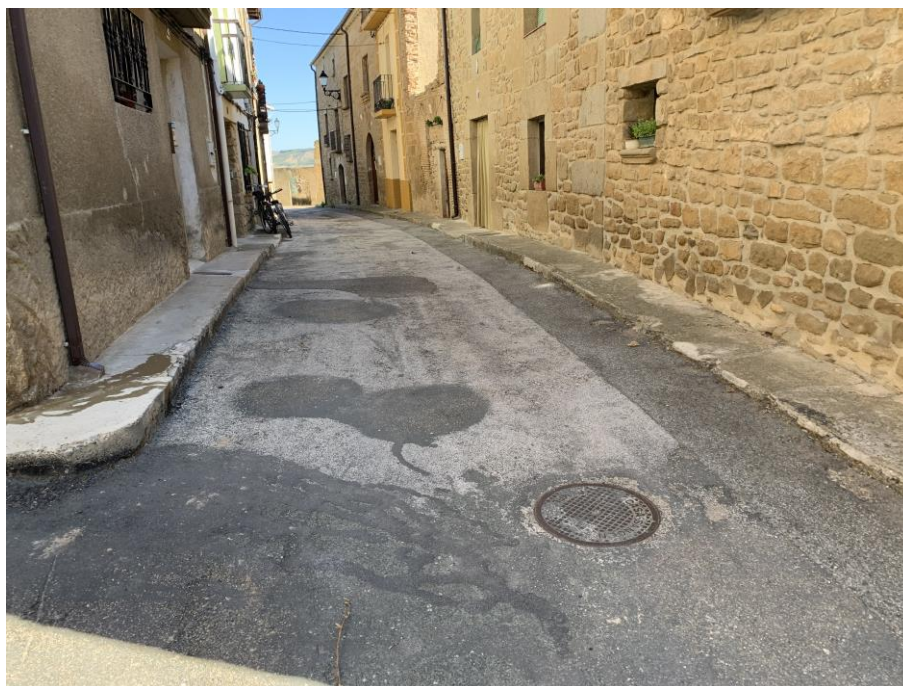
Estado actual Calle Santa María
