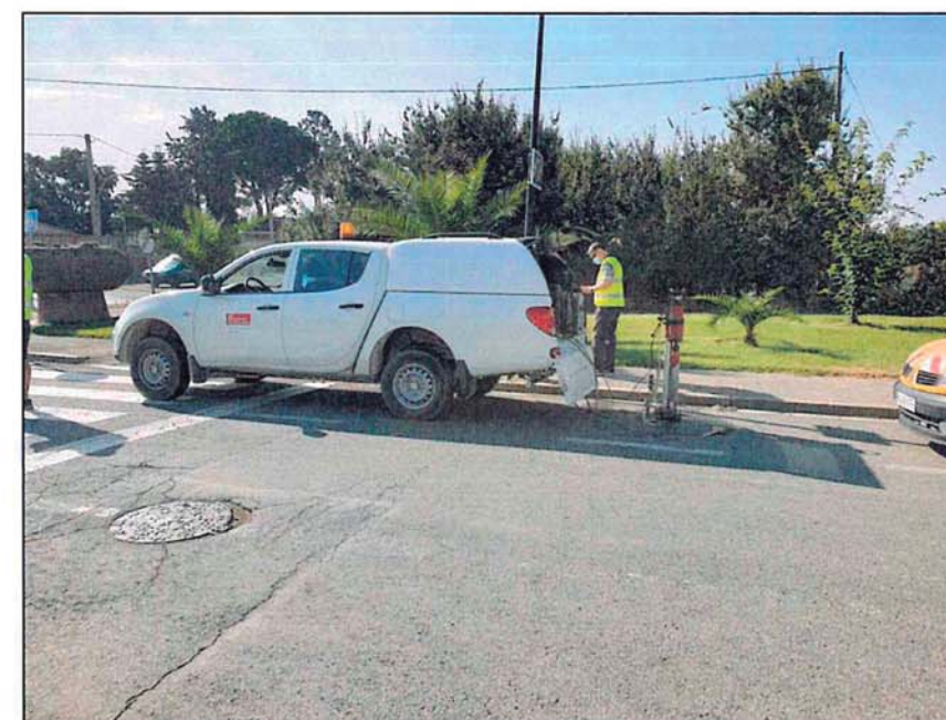
Situación del punto de extracción del testigo de aglomerado en la zona de aparcamiento de la Calle Recreo
