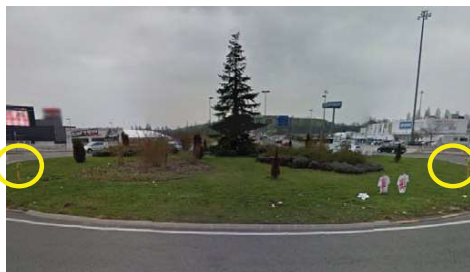
Venteos de gas existentes en interior de Glorieta
