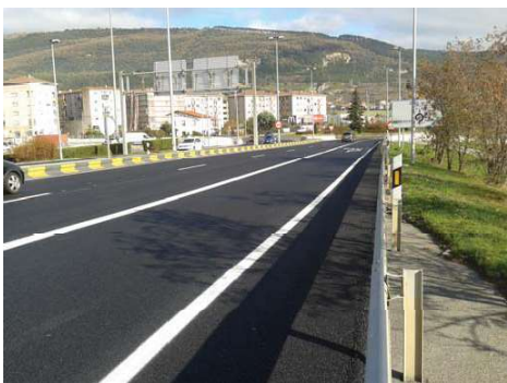
Tramo de la PA-30 con nueva capa de rodadura drenante
