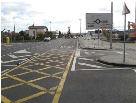
Tramo de la N-240-A modificado
