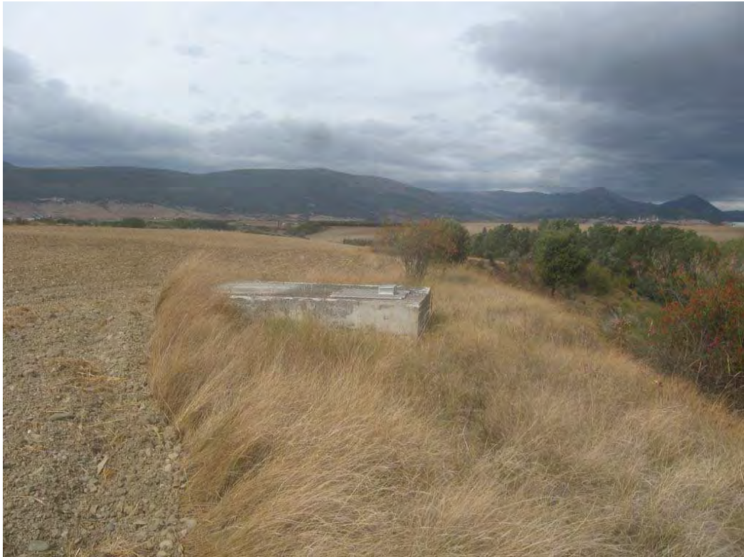
FOTO 7: Arqueta de la conducción de abastecimiento que atraviesa el emplazamiento en estudio.
