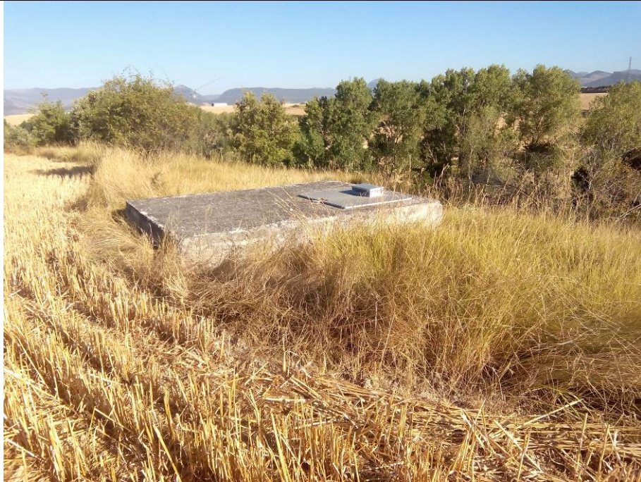
5. Arqueta norte de abastecimiento.
