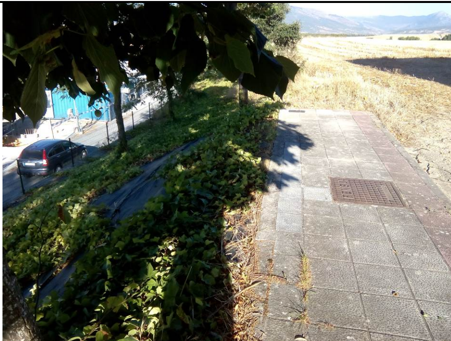
2. Conexión sur a urbanización existente. Arqueta de energía existente.
