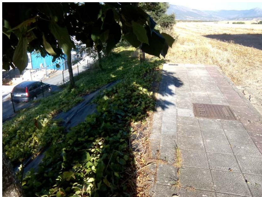
Talud existente en Calle Itxurgain – lado sur.
