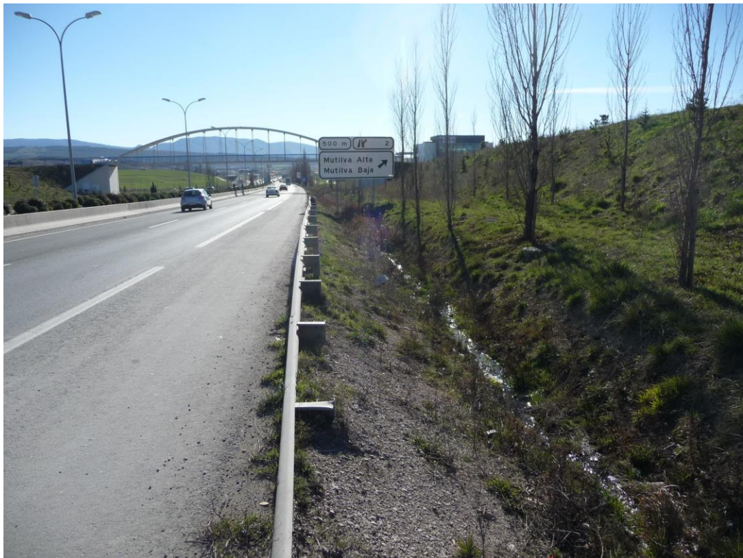
Vista hacia el Sur. Pk 6+980
