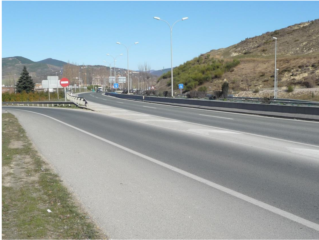
Unión del ramal y de la Ronda Este
