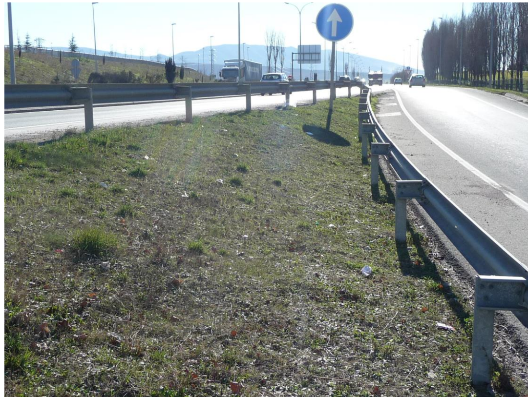
Unión del ramal de Mendillorri en la Ronda Este
