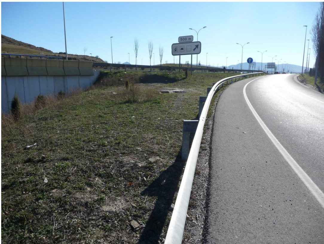
Ramal de salida de Mendillorri
