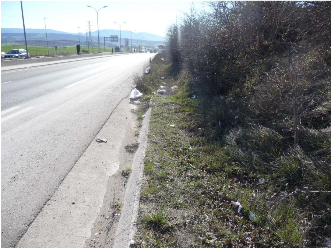
Detalle final de la cuneta. Pk 6+400
