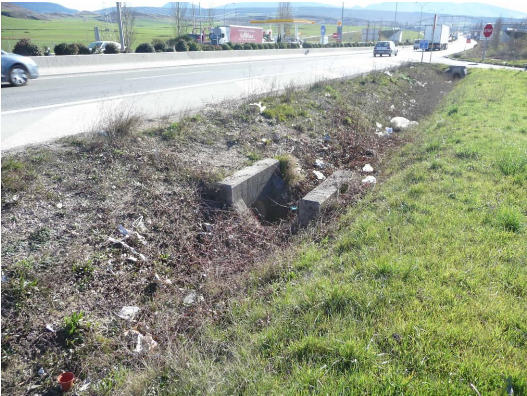
Obra de fábrica junto a la calzada
