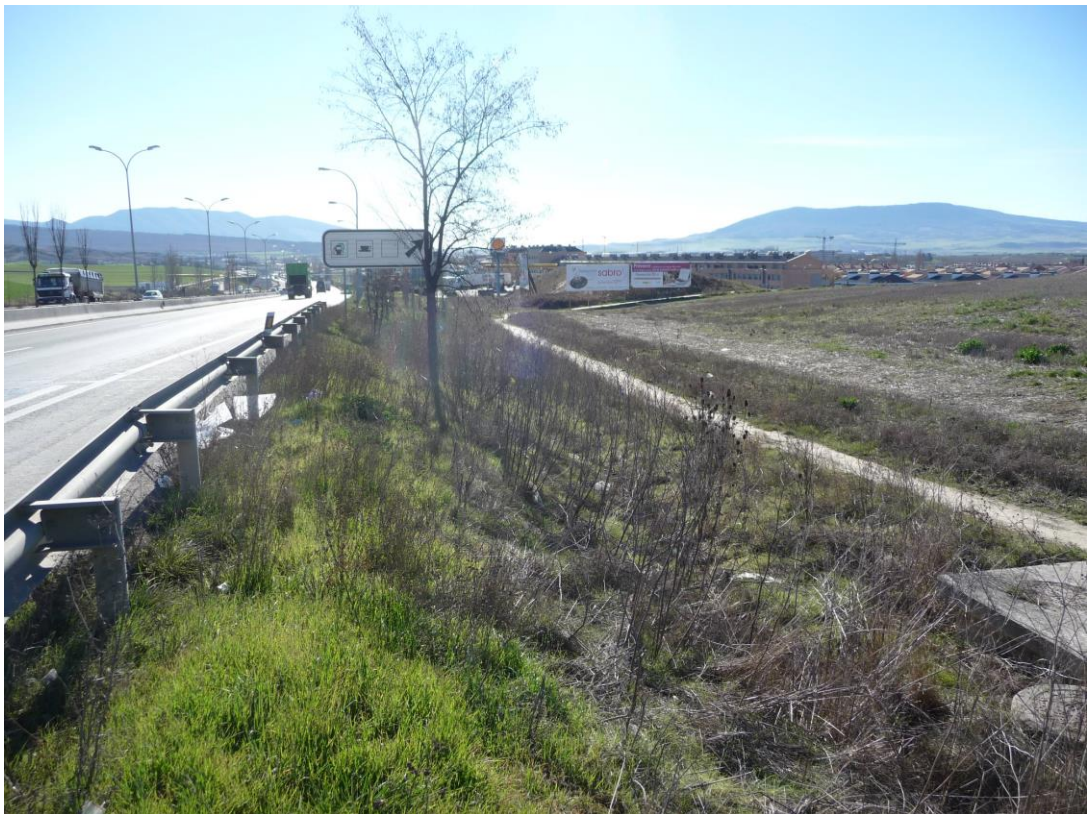
Vista hacia el Sur. Pk 6+600
