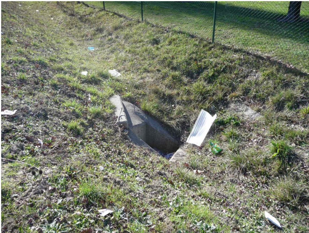
Obra de fábrica en cuneta lateral. Pk 6+230
