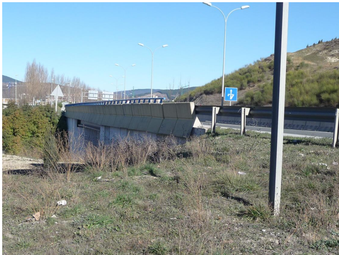
Estructura del Paso Inferior de Mendillorri
