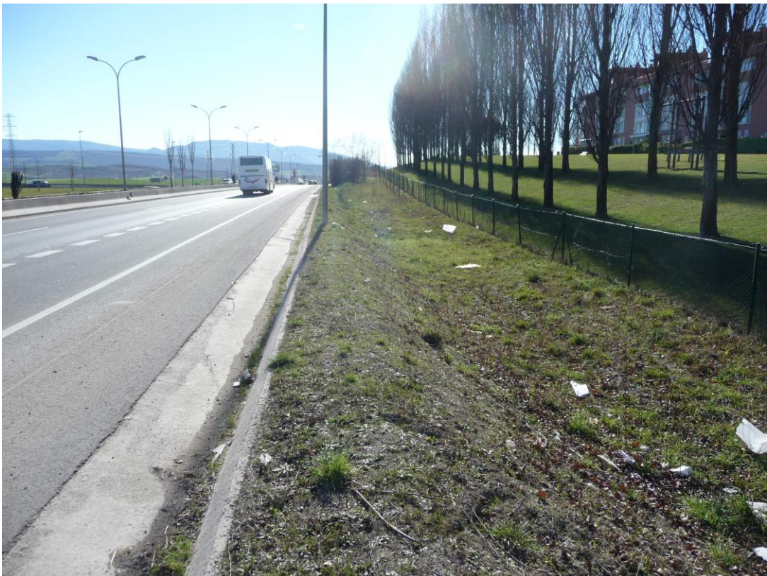
Vista hacia el Sur. Pk 6+300
