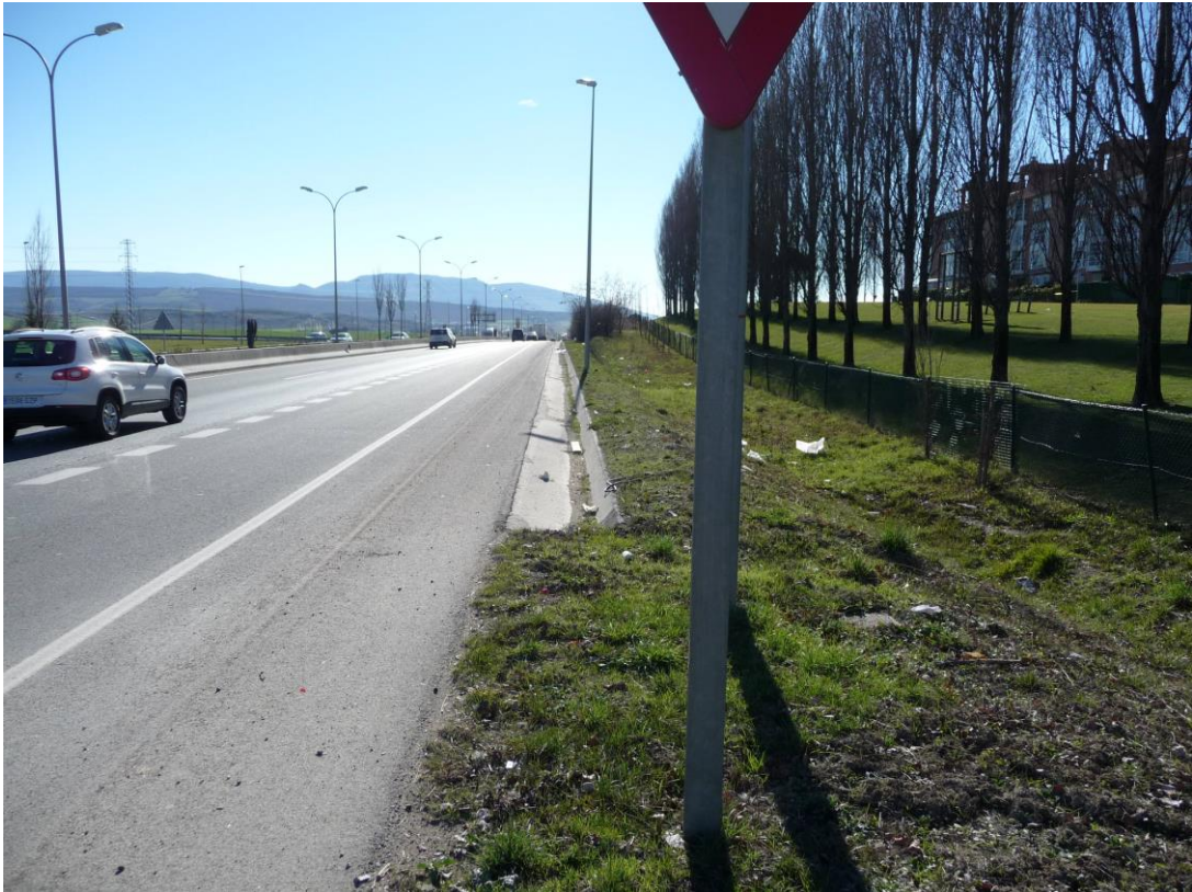
Vista hacia el Sur. Pk 6+250
