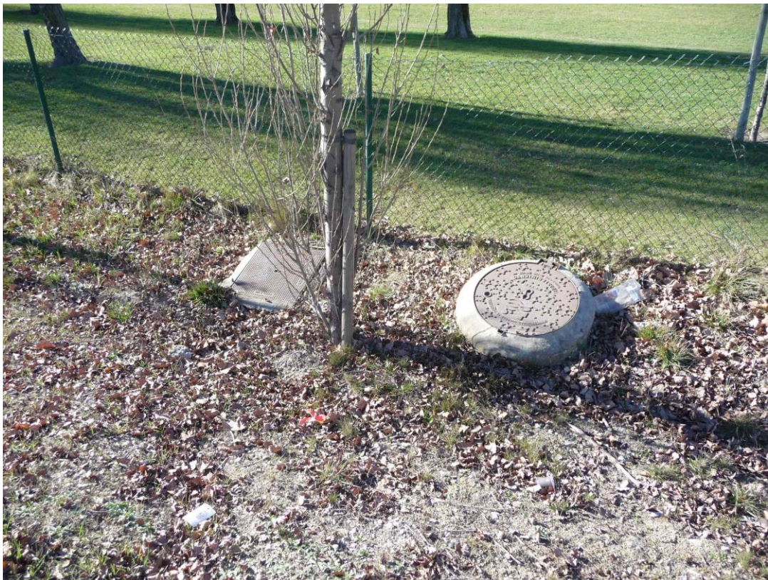
Arquetas existentes. Pk 6+205
