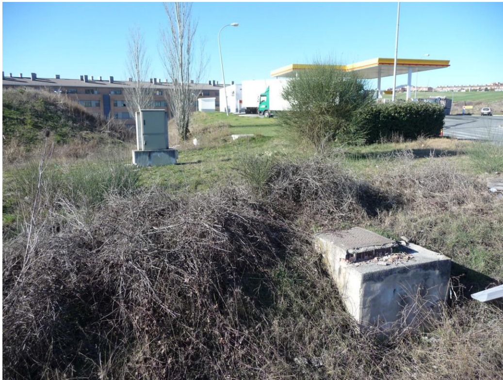
Arquetas de registro pasada la gasolinera
