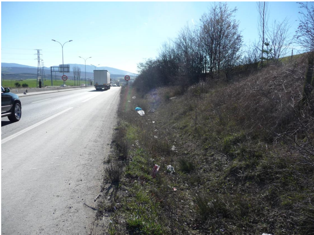
Vista hacia el Sur. Pk 6+500
