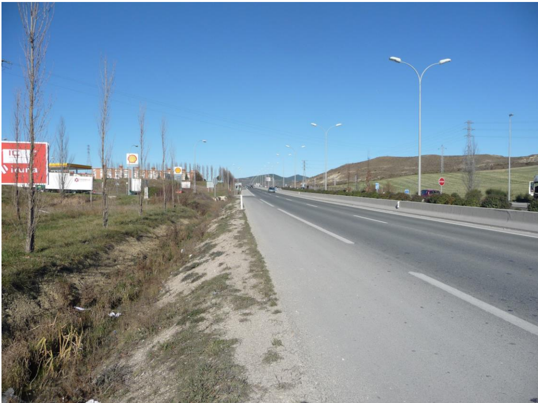
Vista hacia el Norte. Pk 6+980
