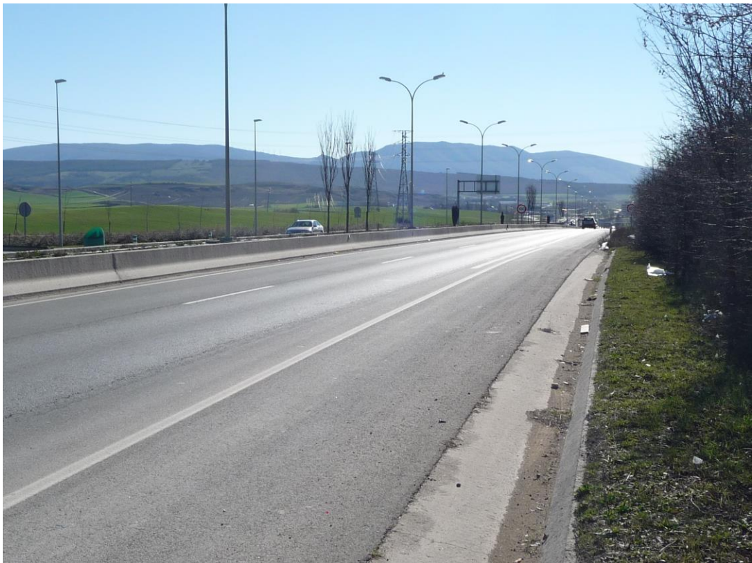
Vista hacia el Sur. Pk 6+350
