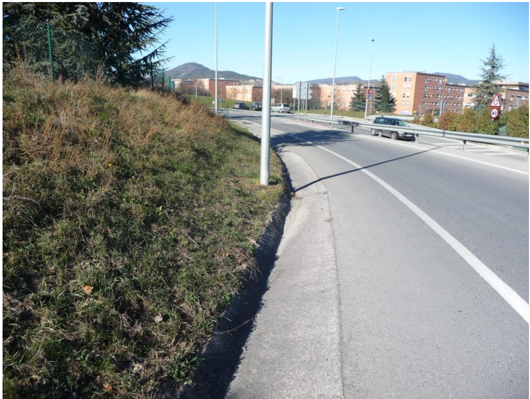
Farola junto a la cuneta
