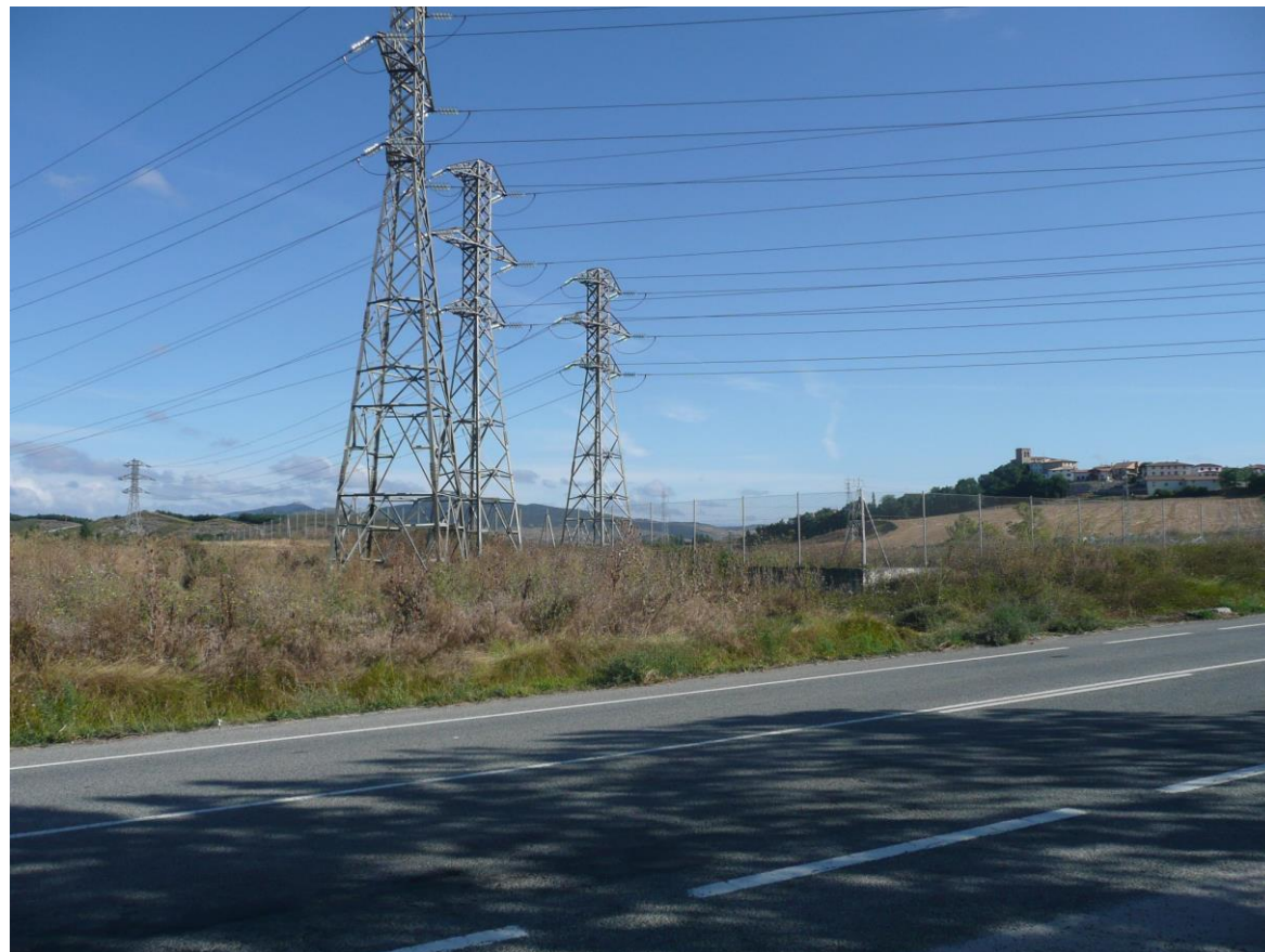
Se observan tres torres de alta tensión en el lado izquierdo de la zona de ampliación de la NA-700
