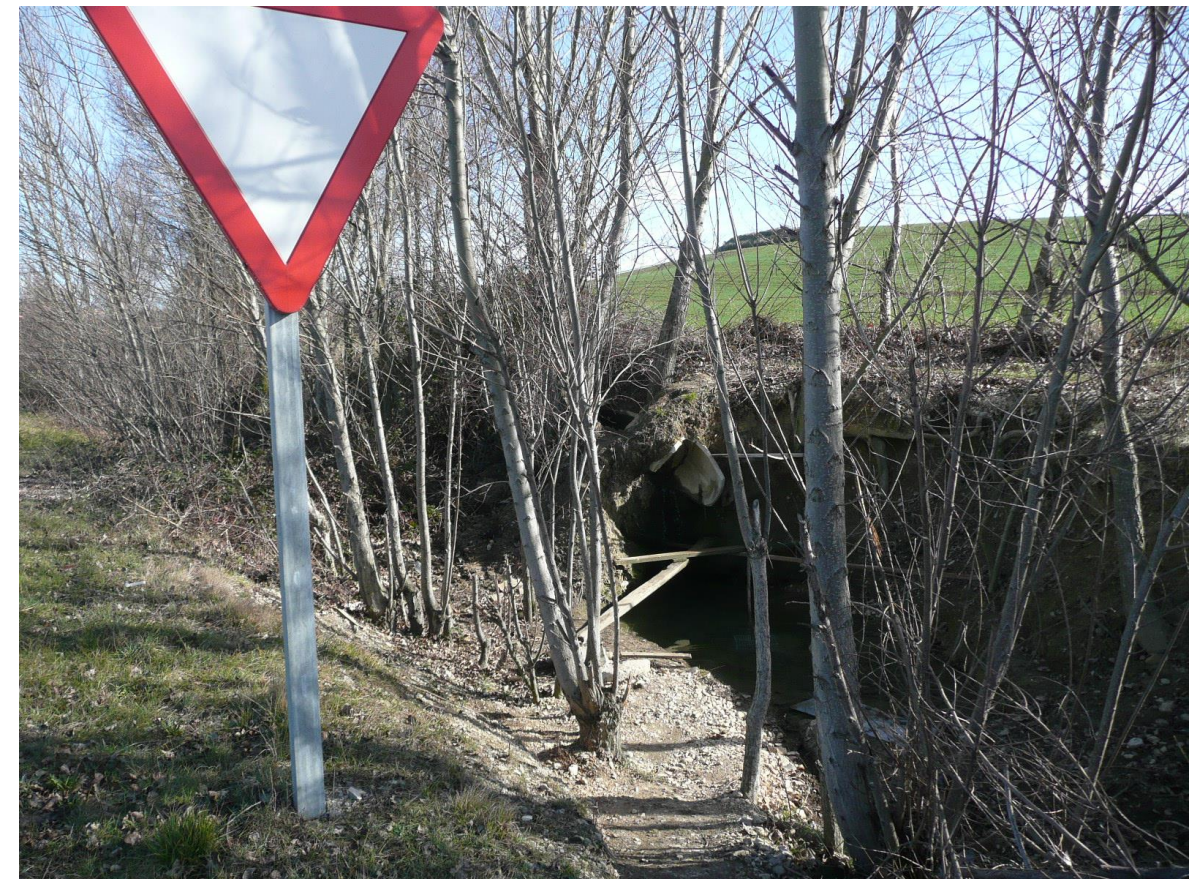
Cuneta existente en el lado hacia Pamplona
