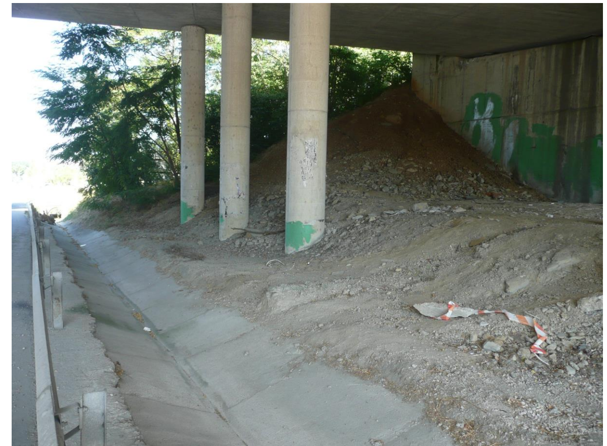
Se observa el Paso Superior (lado derecho). Vista hacia Orkoien.
