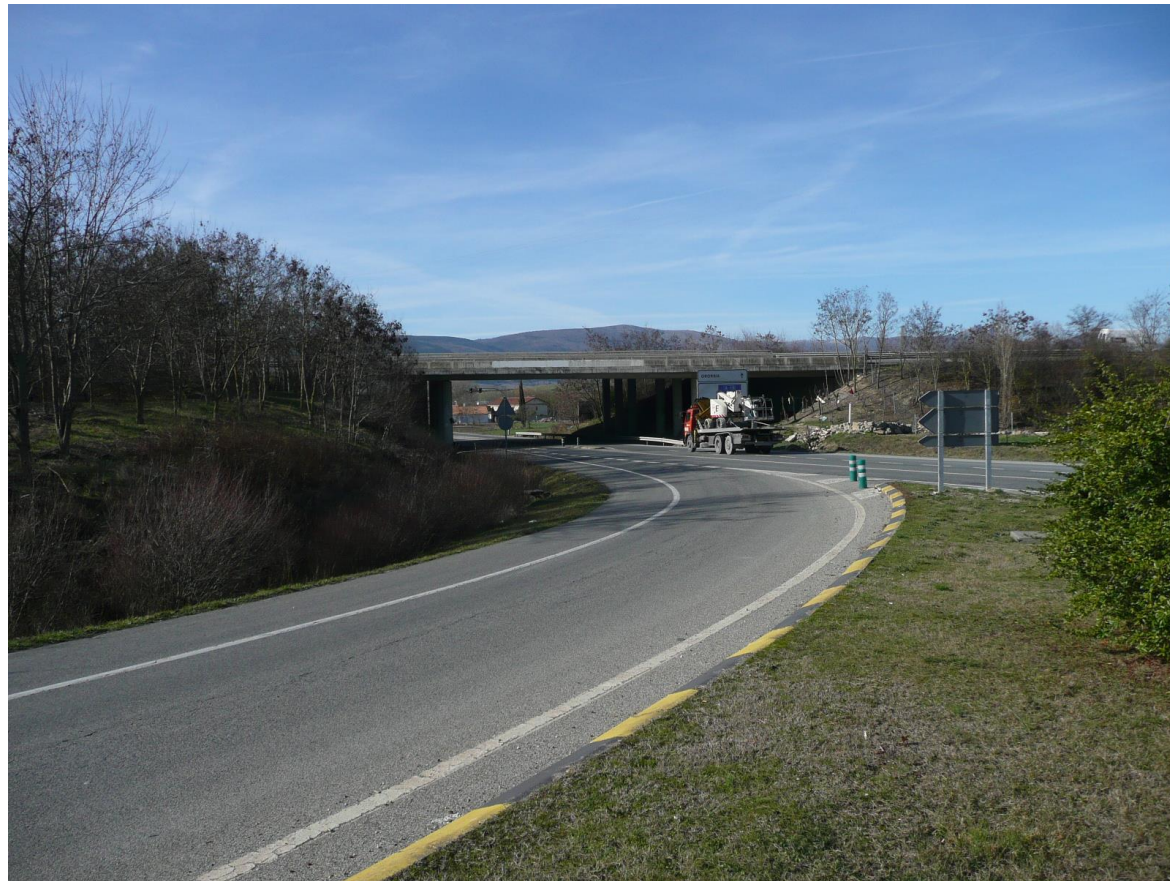
Cuneta existente en el lado hacia Pamplona
