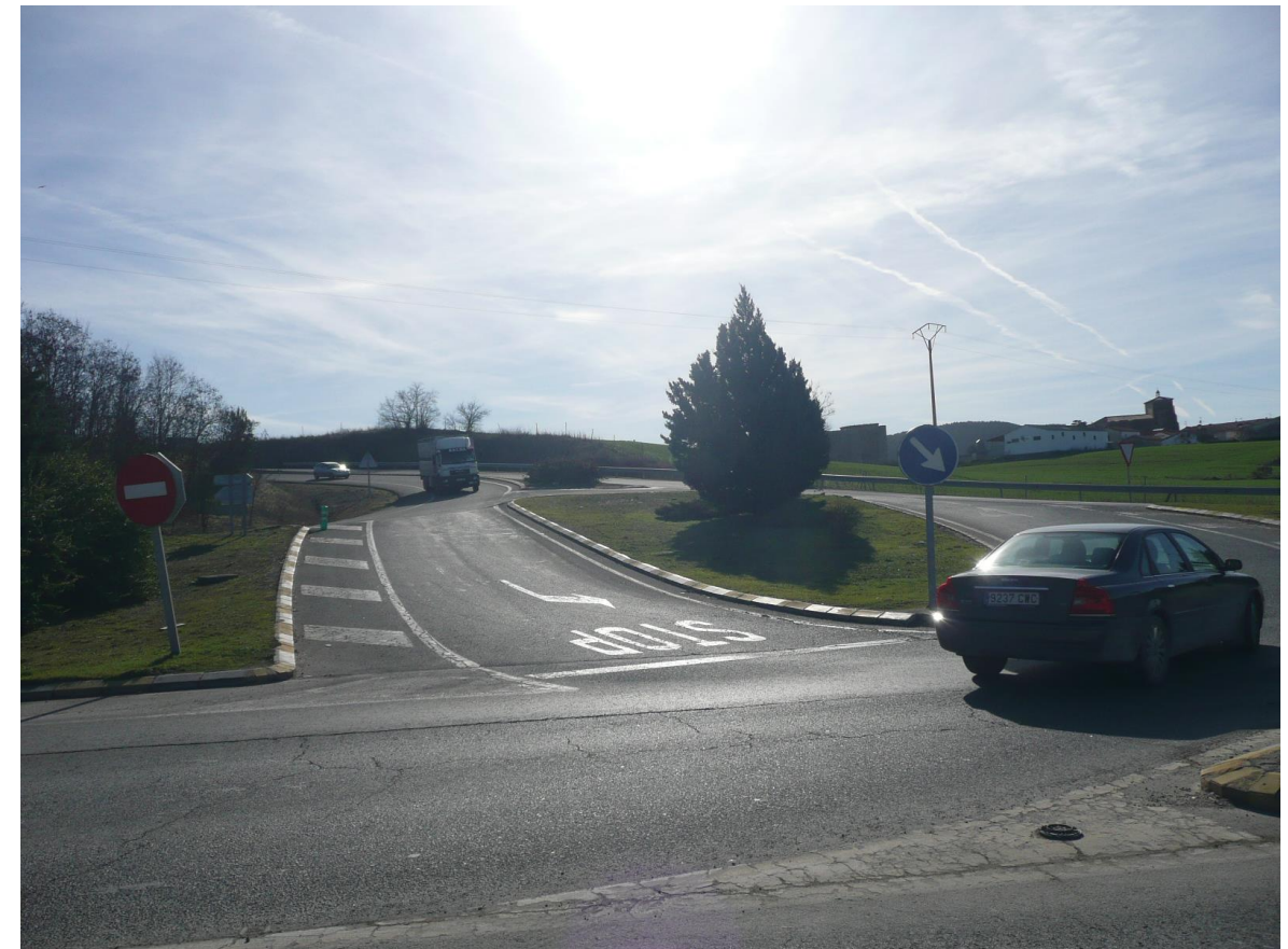
Se observa la pendiente en la intersección de entrada a la Ronda Oeste – Lado Arazuri
