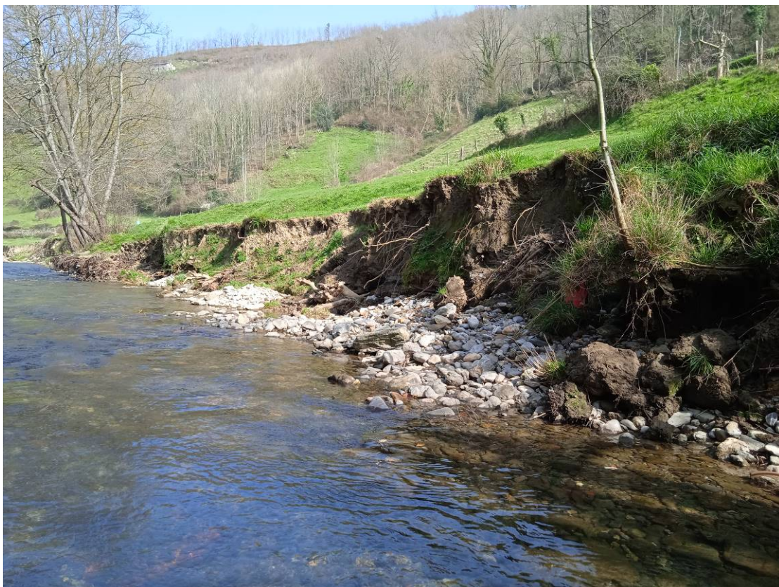
Aspecto “zona a” propuesta protección con krainer simple, lechos y malla orgánica.
