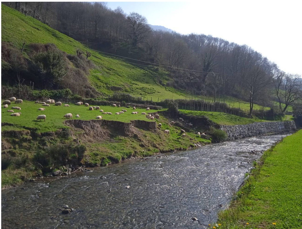
Aspecto erosiones “Zona e” propuesta protección con krainer simple, lechos y malla orgánica
