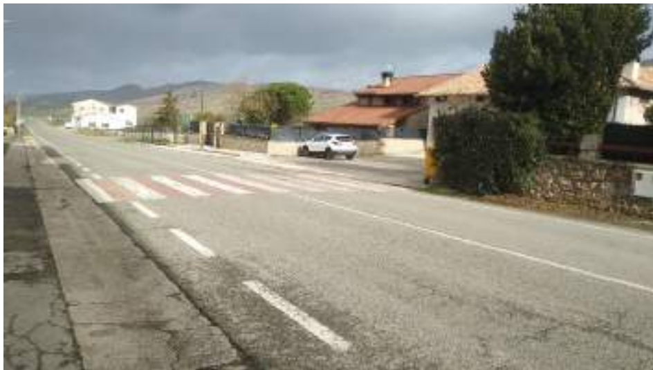
Figura 50. NA-2420. Paso peatones límite de la renovación de la travesía
