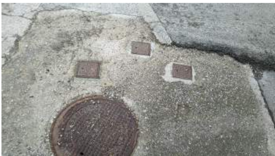
Figura 39. Travesía Monreal. Parada de Bus. Acometidas agua
