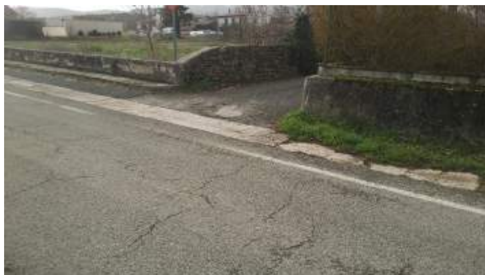
Figura 63. NA-2420. Salida Calle Baritxekoa 1
