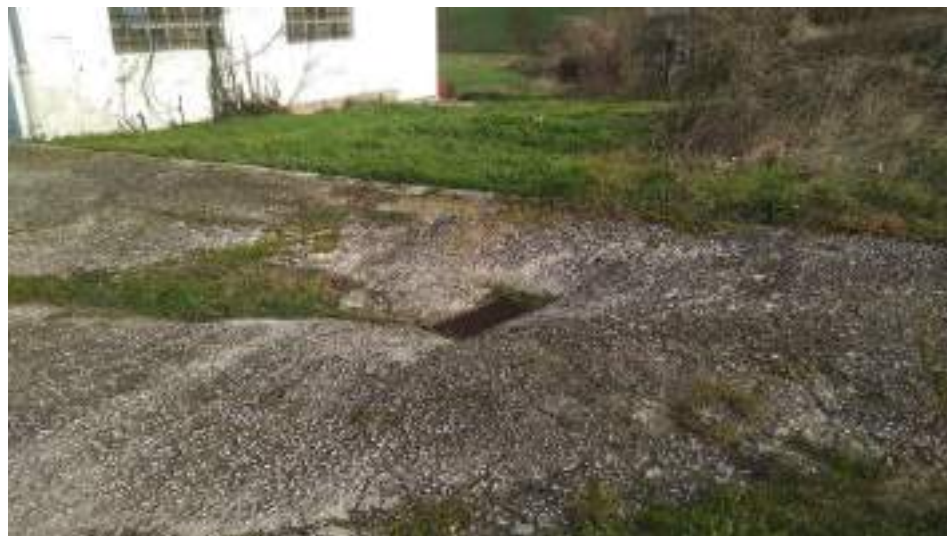
Figura 61. NA-2420. Traza del colector de drenaje. Sumidero
