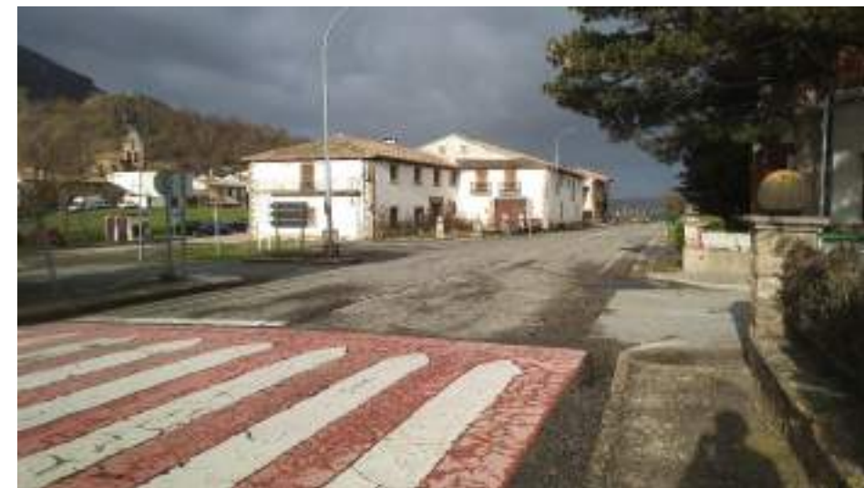
Figura 14. NA-2420. Acceso desde Jaca. Paso de peatones junto a la intersección de acceso a Monreal 2
