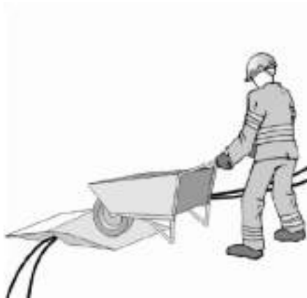
Protección de conductores
