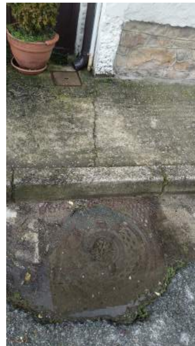
Figura 10. NA-2420. Acceso desde Jaca. Arqueta con inscripción CAMPSA, registro alumbrado y bajante
