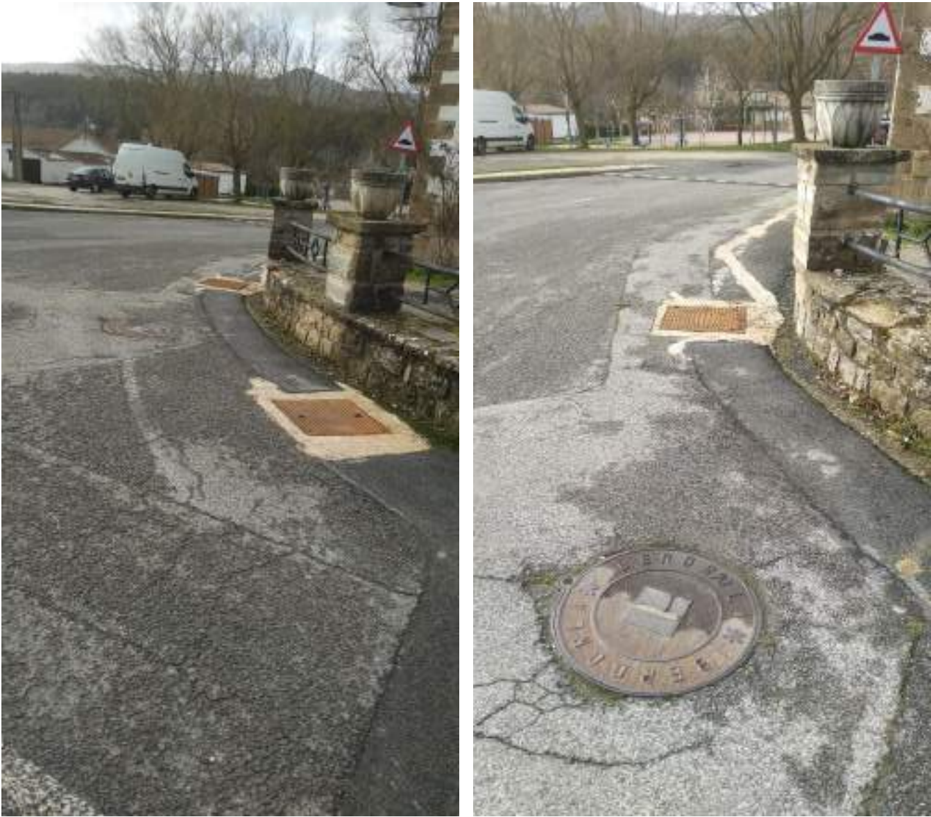
Figuras 27 y 28. Intersección acceso a Monreal. Calle Cuesta Juan Ángel. Canalización telecomunicaciones y arqueta Iberdrola
