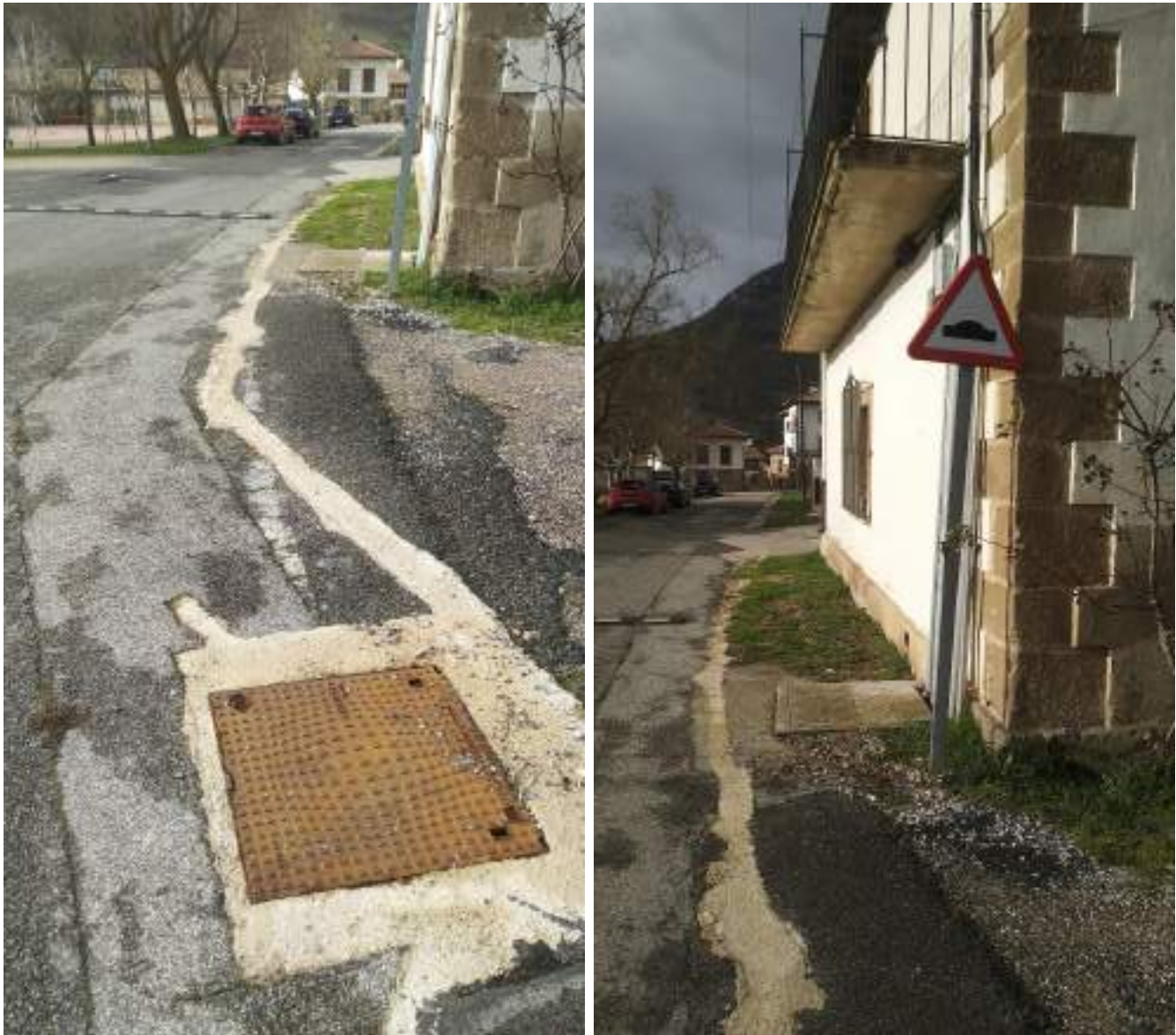
Figuras 29 y 30. Intersección acceso a Monreal. Calle Cuesta Juan Ángel. Canalización telecomunicaciones
