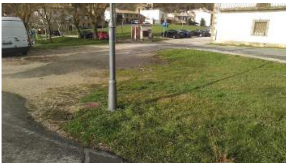
Figura 34. Intersección de acceso a Monreal. Isleta central. Columna de alumbrado y arqueta
