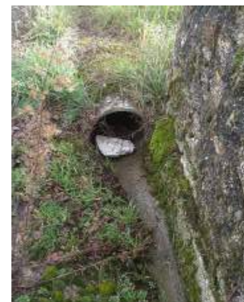
Figura 66. Calle Baritxekoa. Caño de acceso a finca
