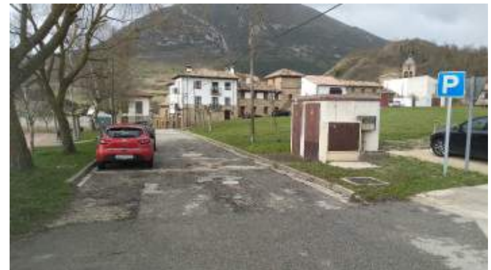
Figura 24. Intersección acceso a Monreal. Calle Cuesta Juan Ángel. Centro de transformación
