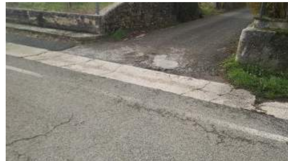
Figura 64. NA-2420. Salida Calle Baritxekoa 2
