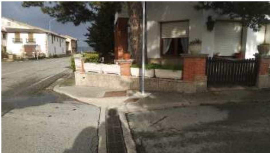
Figura 16. NA-2420. Acceso a calle Alzórriz. Arqueta de electricidad
