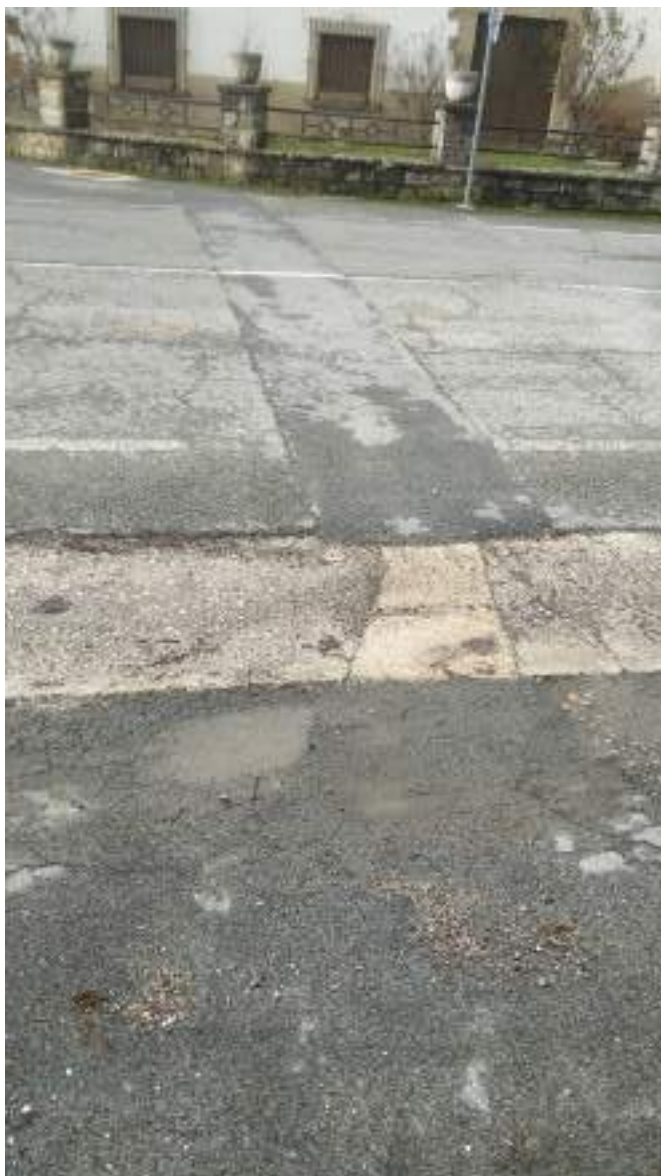
Figura 38. Travesía Monreal. Parada de Bus. Cruce de travesía de canalización telecomunicaciones
