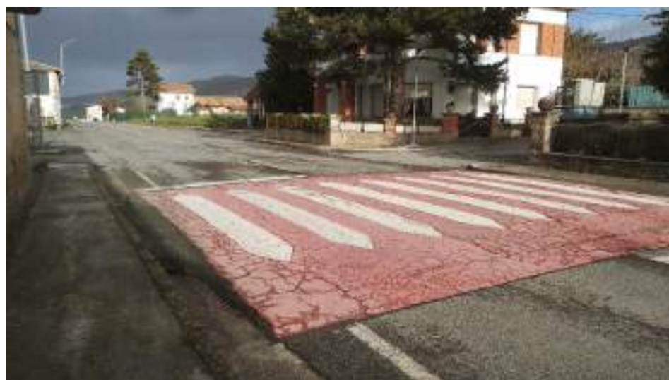
Figura 13. NA-2420. Acceso desde Jaca. Paso de peatones junto a la intersección de acceso a Monreal 1
