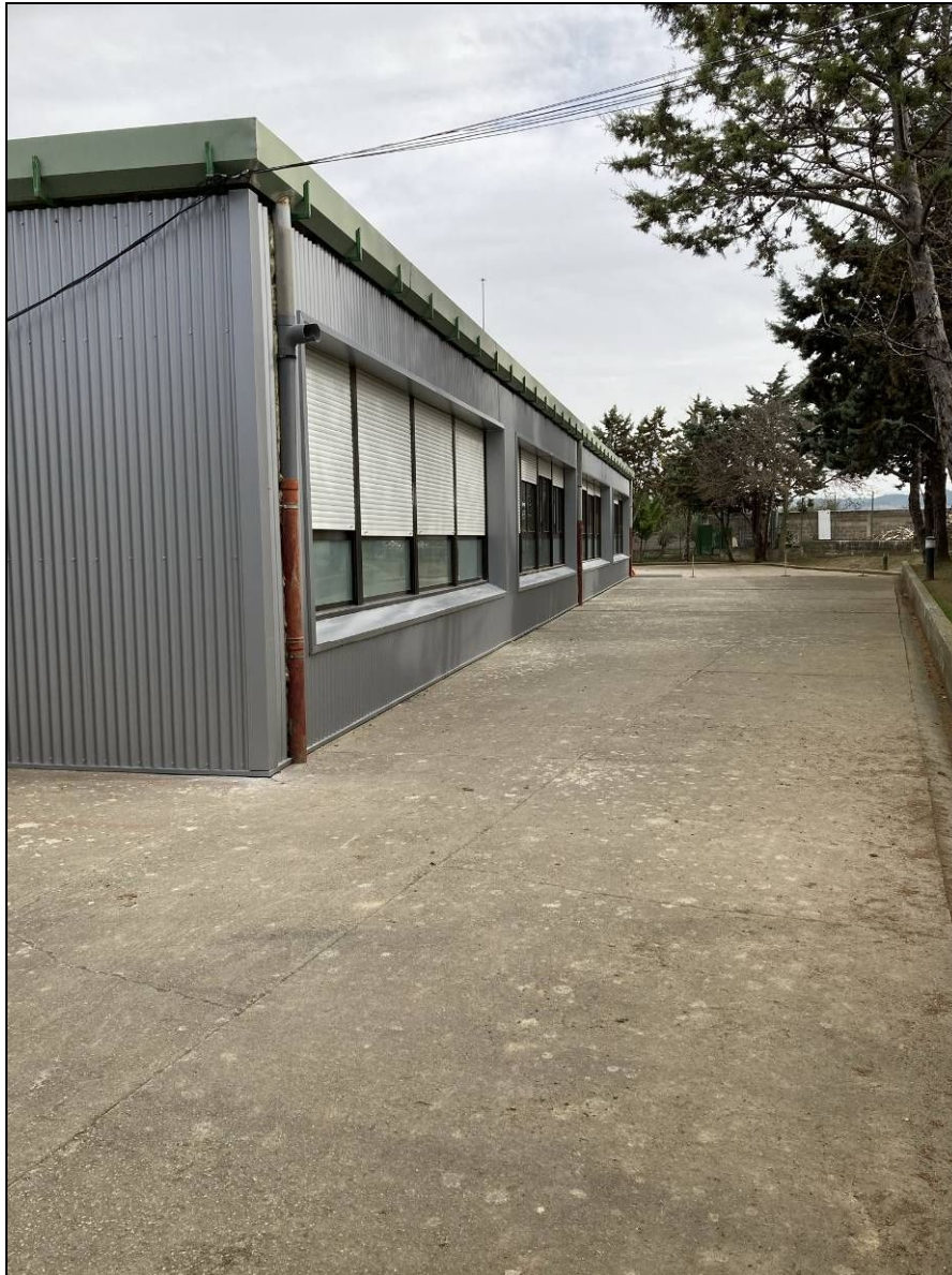
Vista de la fachada sur del colegio.
