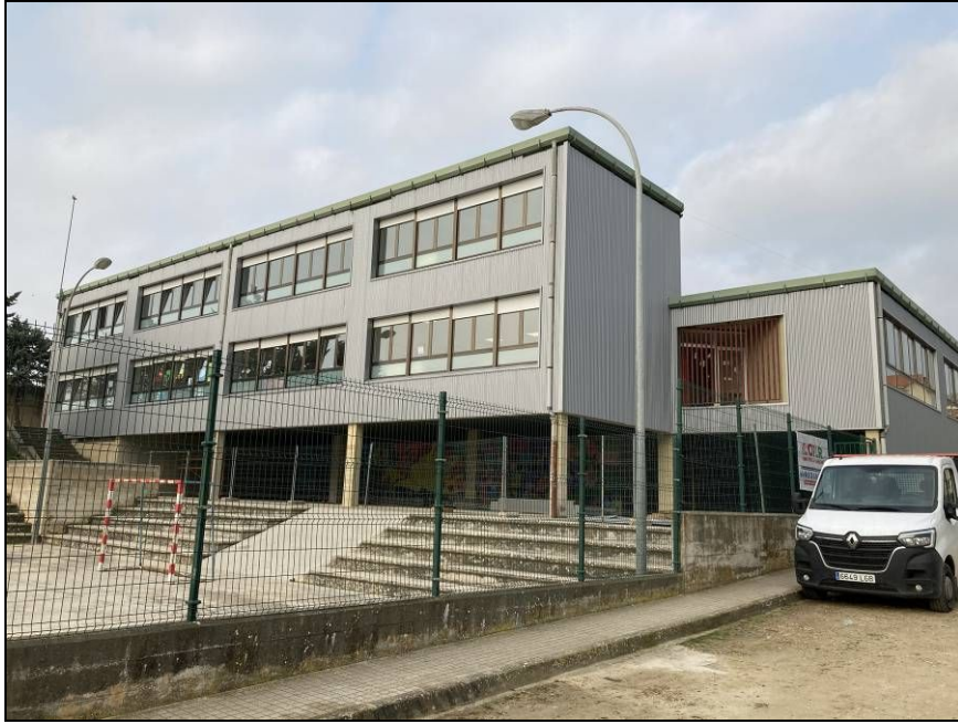
Vista de la fachada este.
