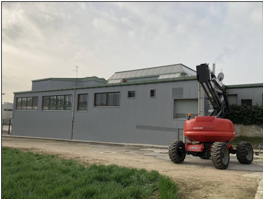
Vista de la fachada norte.
