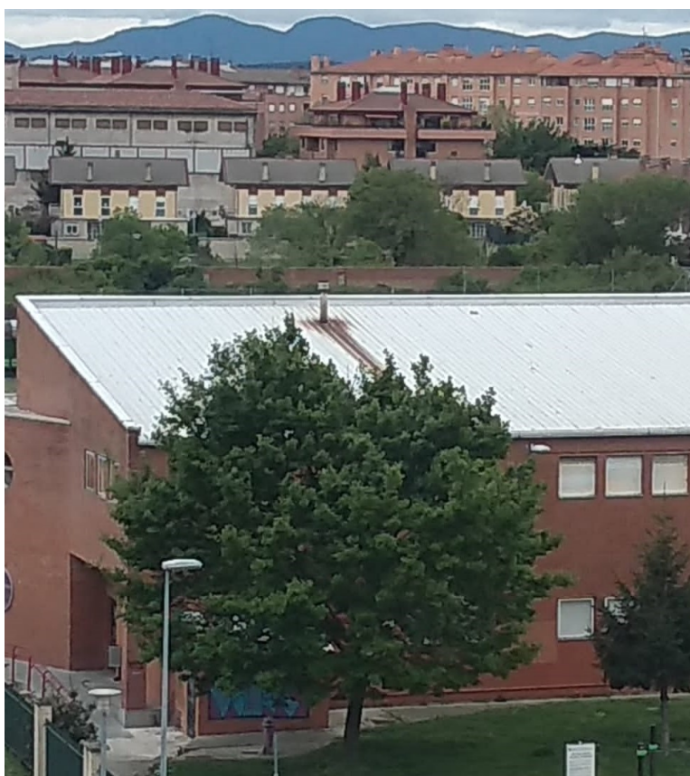
Vista de la cubierta y chimenea existente.
