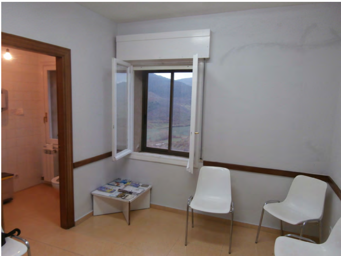
Imágenes estado actual del interior del consultorio, humedades a la derecha de la ventana
