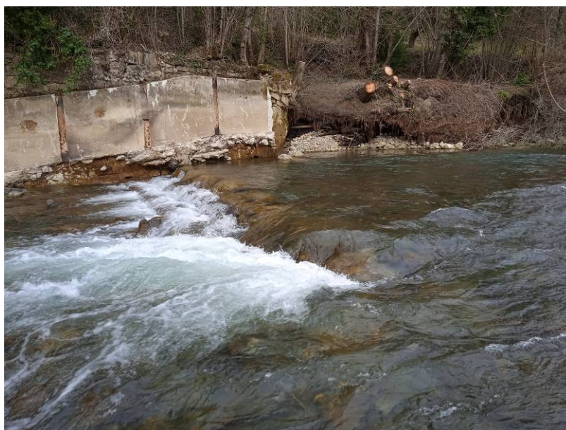
Aspecto pie de presa a demoler
