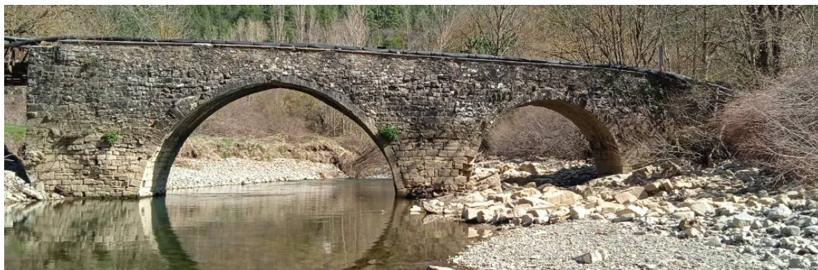
Vista desde aguas abajo del puente
