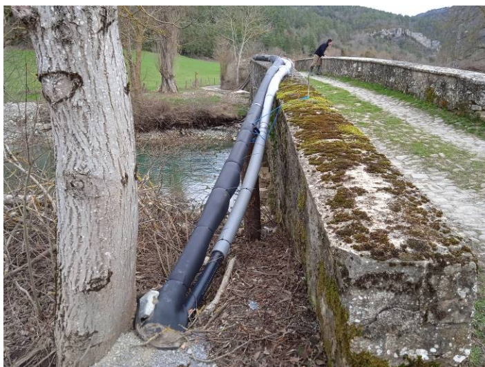
Tuberías provisionales a reitrar
