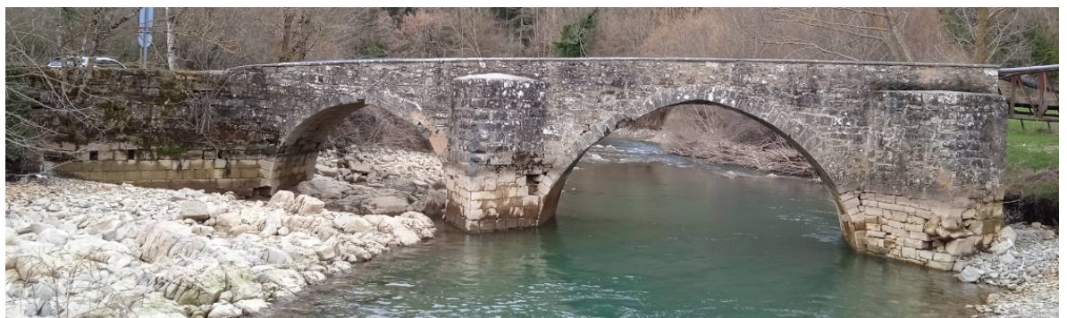
Vista desde aguas arriba del puente
