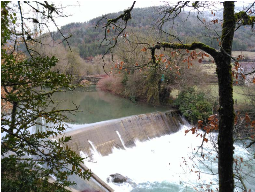
Detalle de presa en avenida
