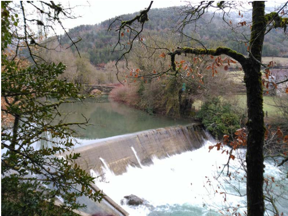
Detalle de presa en avenida
