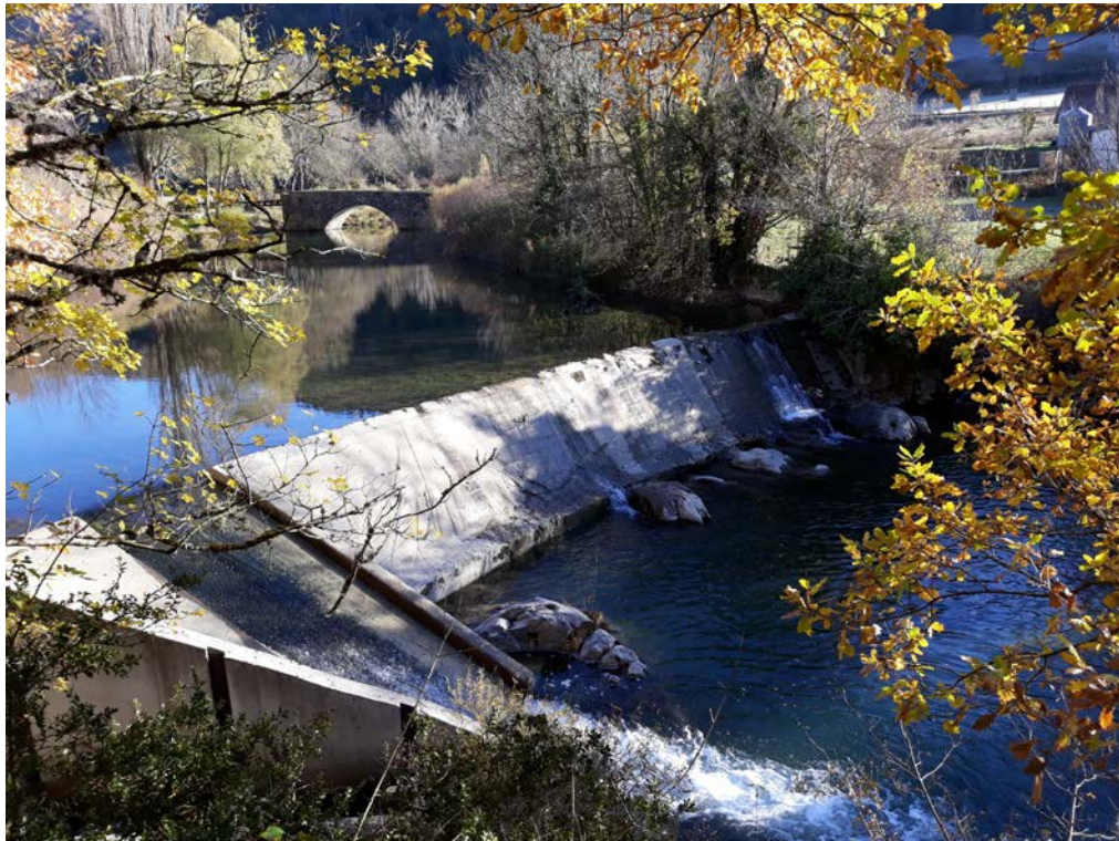
Azud a demoler y rebaje
