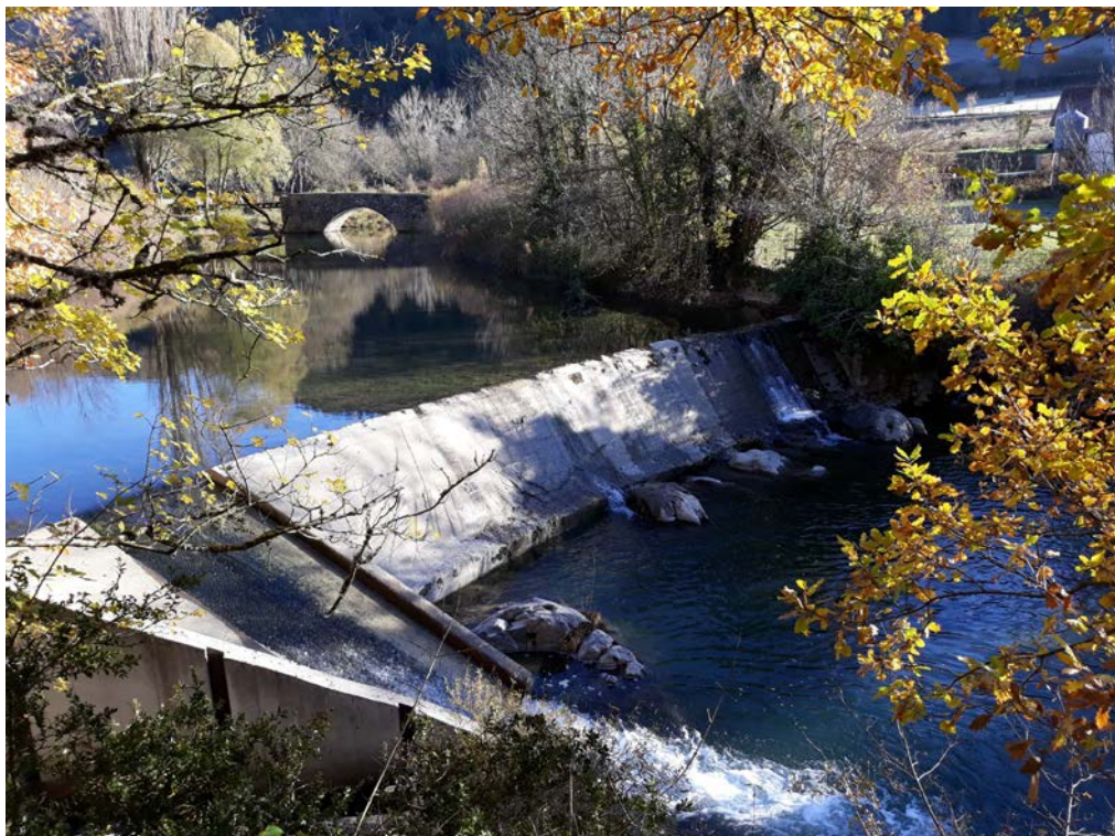
Azud a demoler y rebaje
