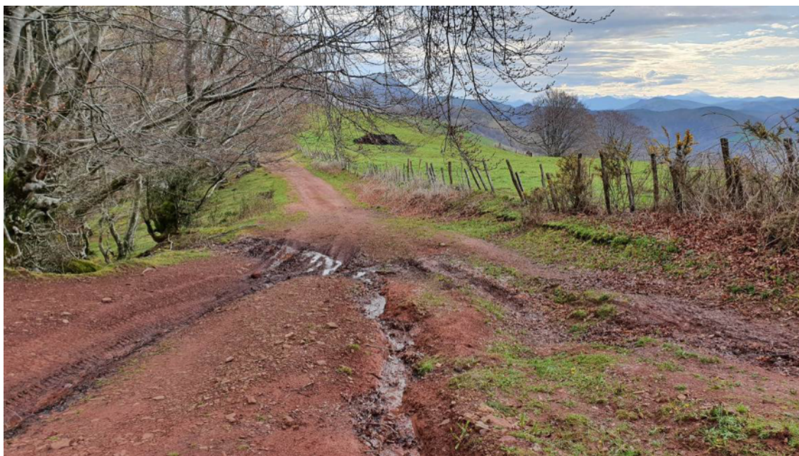
Fotografía donde se aprecia el mal estado de la explanación con regueros y capa de rodadura inexistente pista Aizpitz-Meaka
