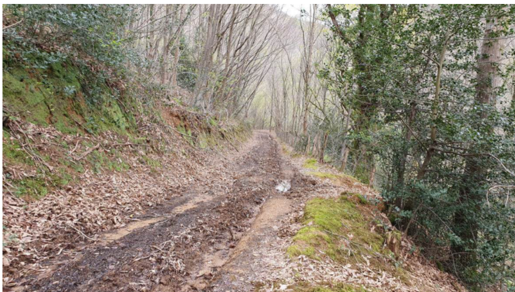
Fotografía donde se aprecia el mal estado de la explanación con regueros y capa de rodadura inexistente pista Egurtegi.
