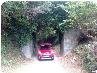
Foto 3.9: PI entorno Km 1,35 de la vía Verde
