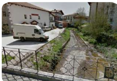
Foto 4.4: Tramo Arrieta nº 50, nº47-49
