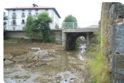
Foto 4.5: Puente travesía Lekunberri
