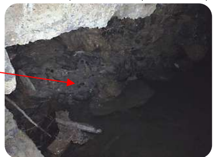
Fot 5.8: Pérdida hastial 3-4m y anchura 0,5-1m
