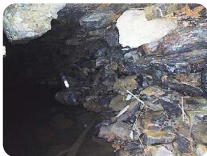
Fot. 5.9: Socavón MD abarca >1m de anchura
