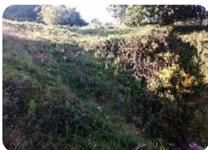
Fot. 5.23: MD del talud de la B. Sur
