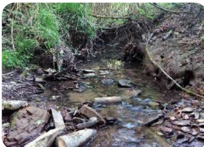
Fot. 5.21: Vista cauce aguas arriba desde ODT
