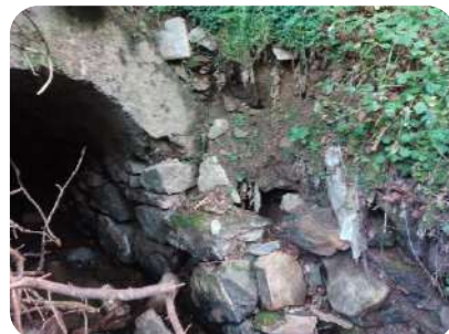
Fot.5.3: Riesgo derrumbe aletas MD (B.Norte)
