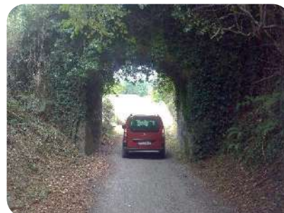
Foto 3.10: PI entorno Km 1,35 de la vía Verde
