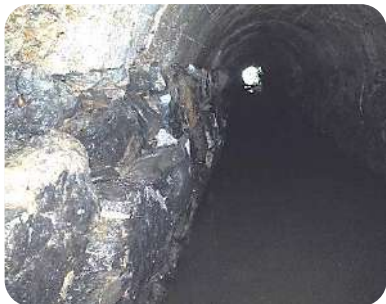
Fot. 5.10: Hastiales de mampostería en las zonas "sanas" y cúpula de hormigón en masa.
