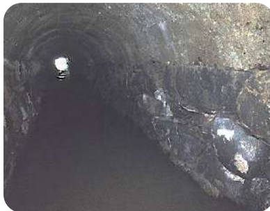
Fot. 5.10: Hastiales de mampostería en las zonas "sanas" y cúpula de hormigón en masa.
