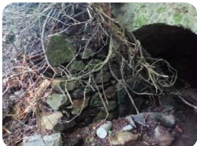
Fot. 5.1: Riesgo derrumbe aletas MI (B.Norte)
