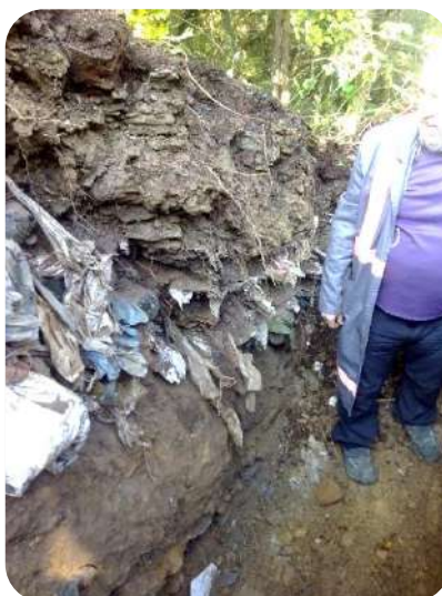
Foto 7.2: Sección relleno lateral Oeste zanja
