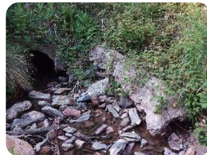
Fot. 5.13: MI salida B. Sur. Resto HOR conexión ODT original y prolongación Tubería
