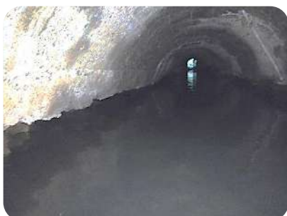
Fot. 5.14 Desaparición hastiales MD Boca Sur
