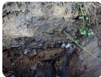
Fot7.9: Sección zanja y canalización eléctrica
