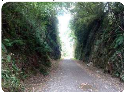
Foto 3.8: Tramo inicial en trinchera Vía Verde
