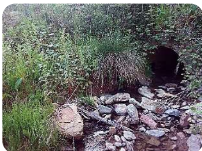
Fot. 5.11: MD salida Boca Sur. La alineación de la ODT está girada 30° respecto al cauce
