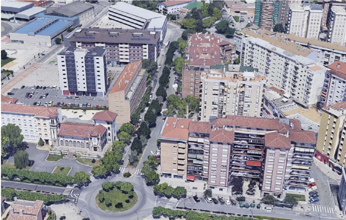
Imagen aérea de la calle Bidaburua.
