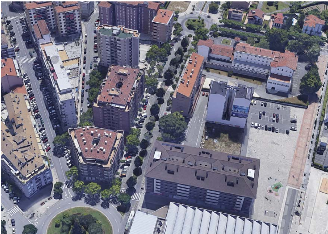
Imagen aérea de la calle Bidaburua.
