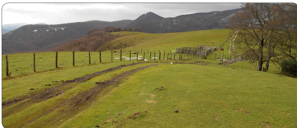
vista del tramo de pista a mejorar. Se aprecia como se forma barro con el paso de vehículos con suelo húmedo.
