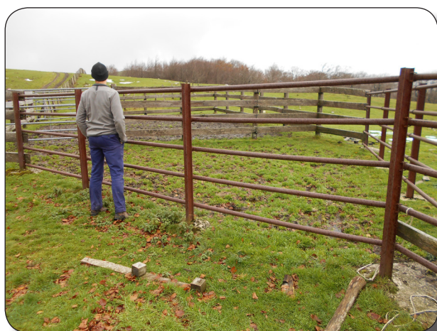
Vallado de la manga de Txasperro. Las flechas indican la altura de los tabloncillos a colocar
