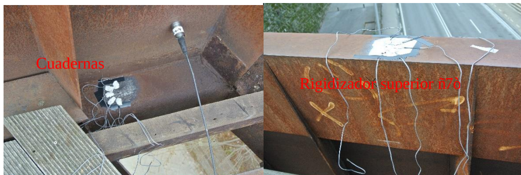
Detalle de ensayos de Hole Drilling en cordón inferior y superior
