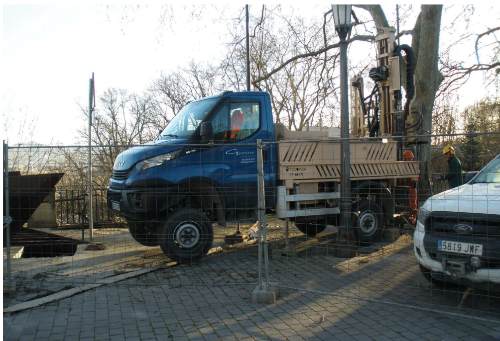
FOTO 8: Máquina de sondeos emplazada en el estribo de Media Luna (SM-2).
