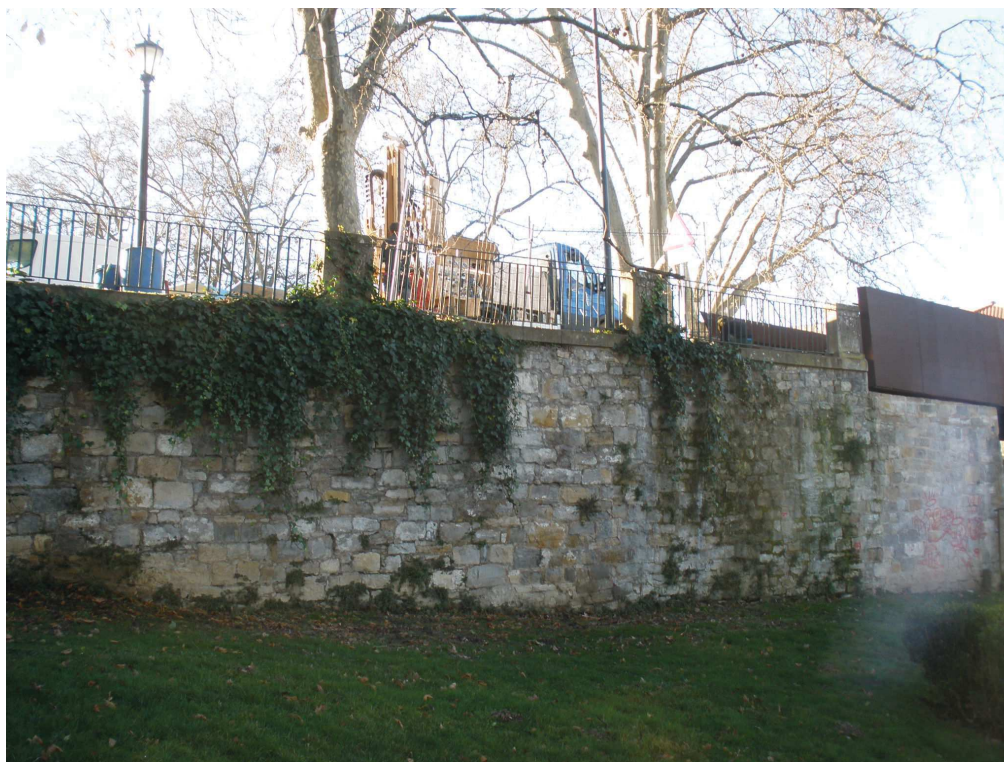
FOTO 4: Vista lateral de la muralla en el estribo Media Luna con la máquina de sondeos emplazada.
