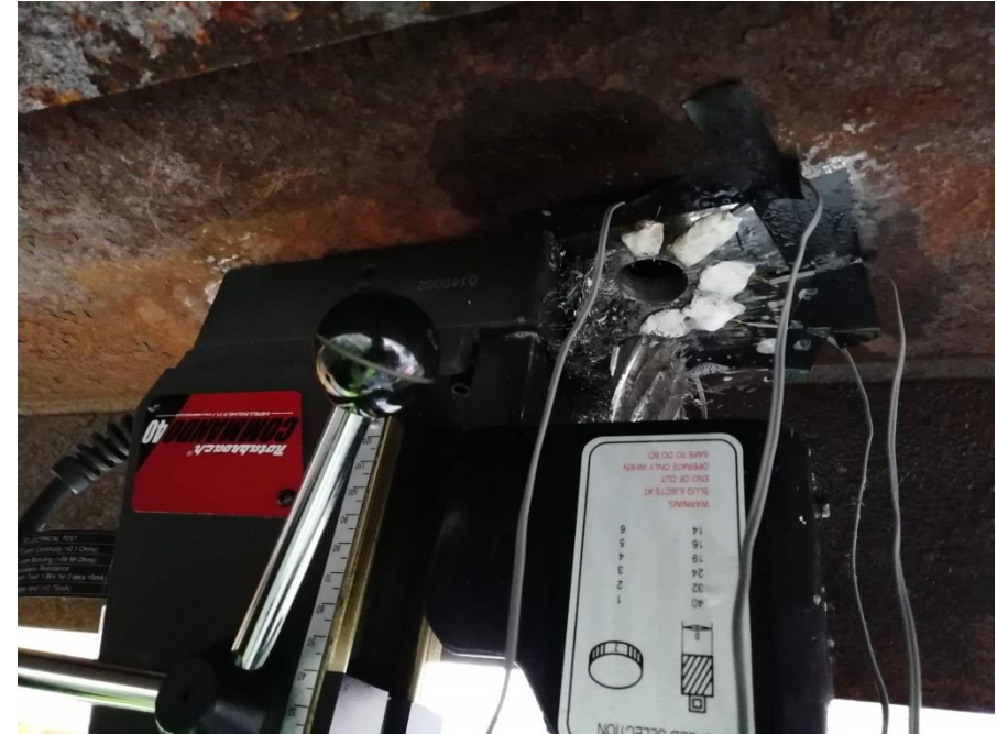
Ilustración 3. Hole-Drilling Nudo inferior.
