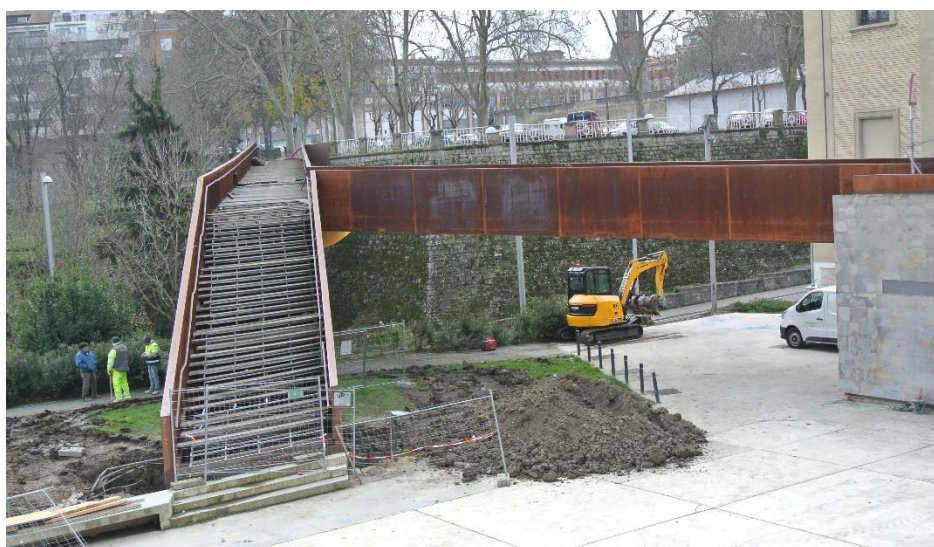
Estado actual de la pasarela
