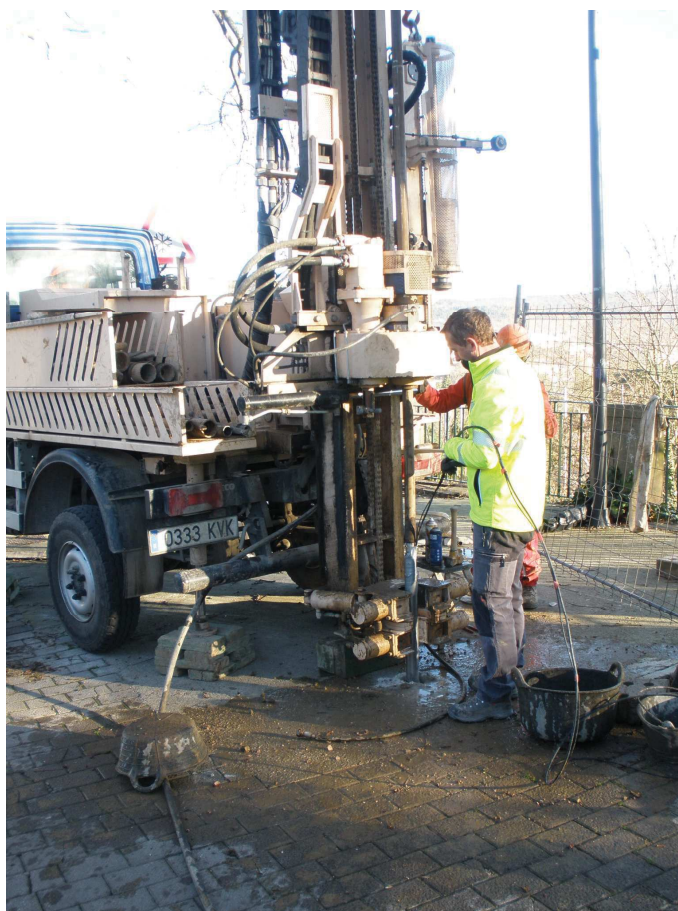
FOTO 9: Preparación para la ejecución de un ensayo presiométrico en el sondeo SM-2 (estribo Media Luna).
