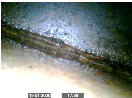
Interior de viga de apoyo estribo Jito Alai. Presencia de agua, delaminaciones y corrosión en cordón inferior
