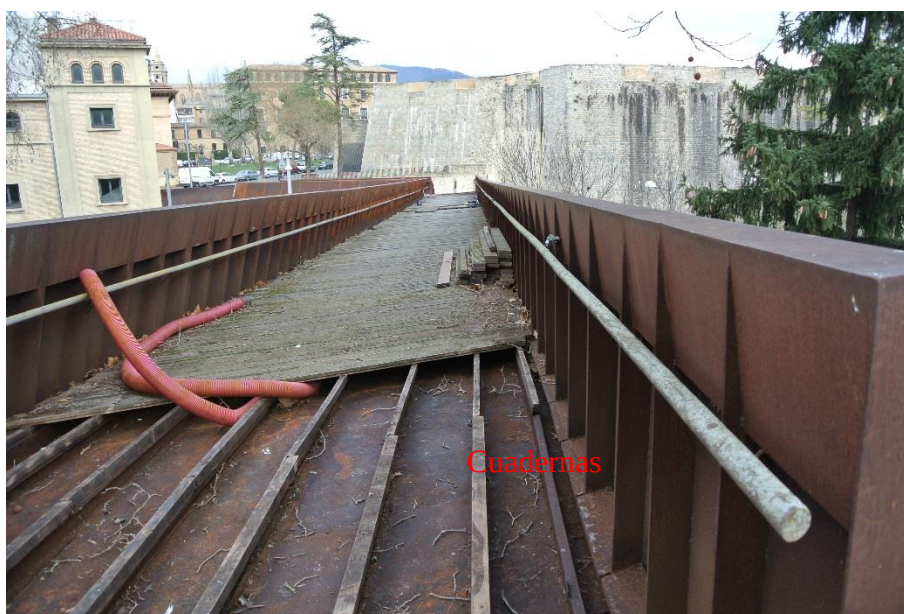
Detalle del cordón superior visto desde el estribo de Media Luna
