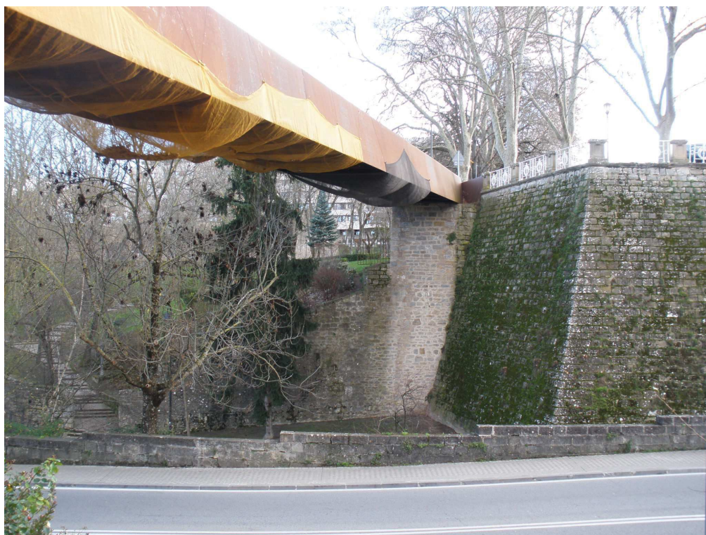
FOTO 3: Vista general de la pasarela y del estribo de la Media Luna.
