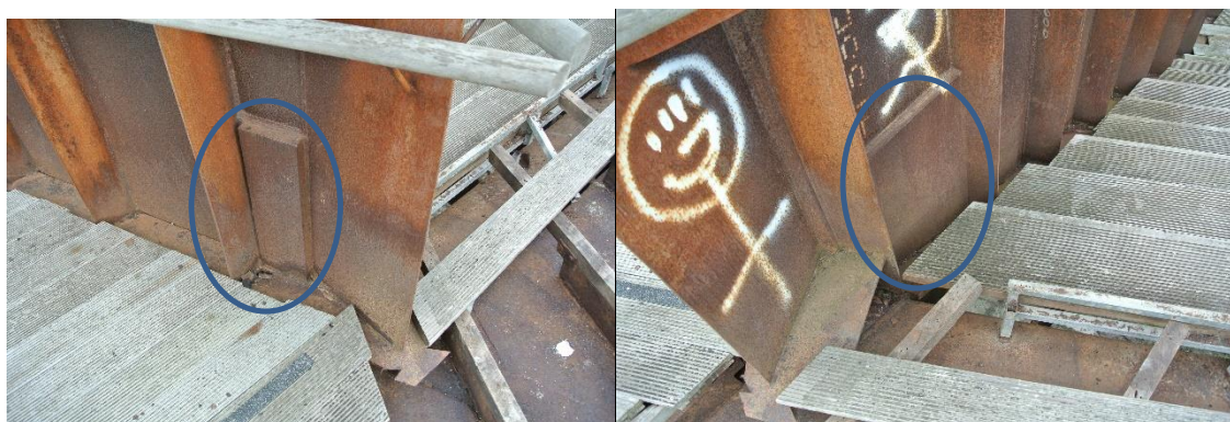
Detalle de los refuerzos en la unión de la rampa con la escalera
