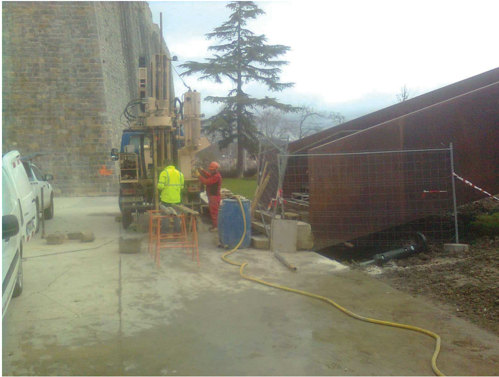
FOTO 5: Máquina de sondeos emplazada en el estribo de Jito Alai (SM-1).
