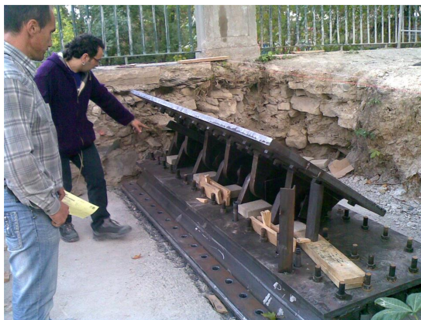
Detalle de articulación trasera en Media Luna
