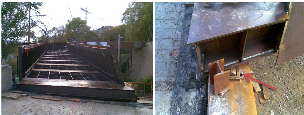
Detalle de apoyo en frontón de Labrit (*)
