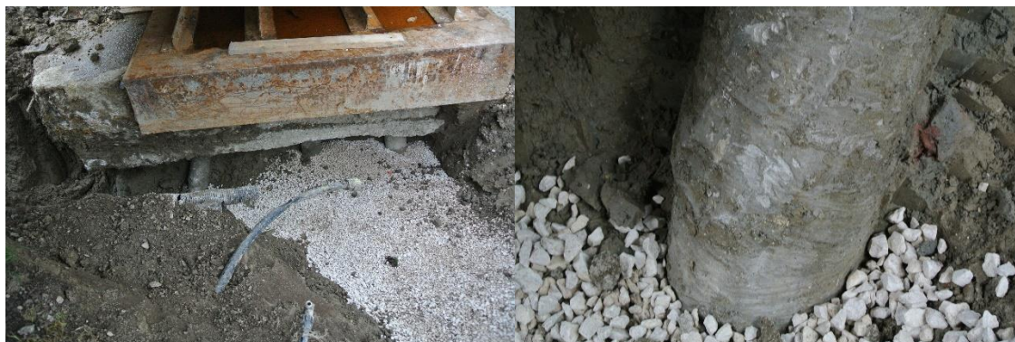
Detalle del fondo del encepado de Jito Alai y de los micros
