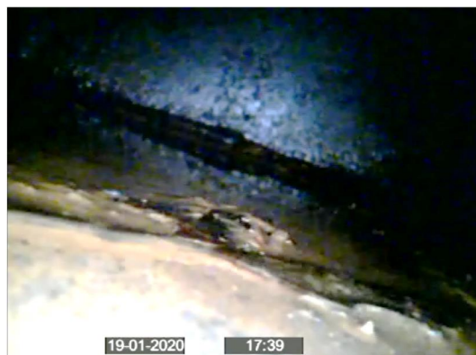
Interior de viga de apoyo estribo Jito Alai. Presencia de agua, delaminaciones y corrosión en cordón inferior
