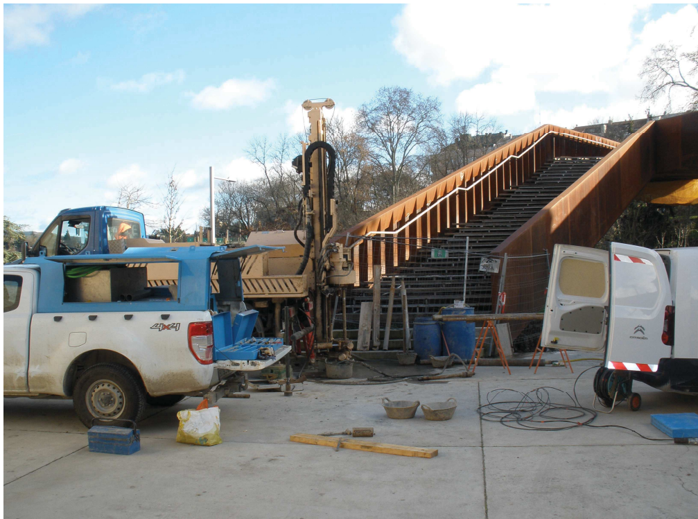
FOTO 6: Sondeo SM-1 en ejecución, en el estribo de Jito Alai.
