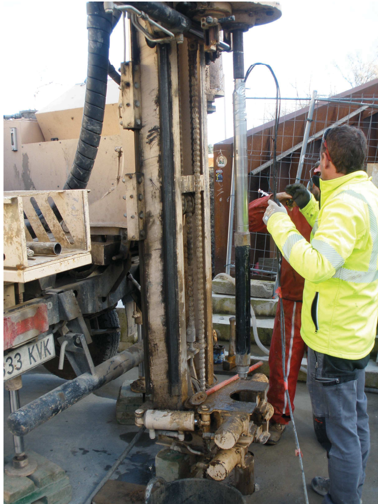
FOTO 7: Preparación para la ejecución de un ensayo presiométrico en el sondeo SM-1 (estribo Jito Alai).
