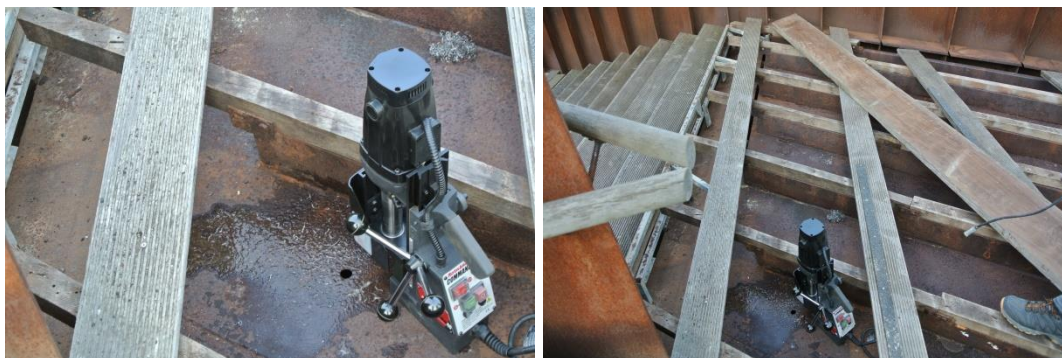
Detalle de ejecución de agujeros con el taladro magnético
