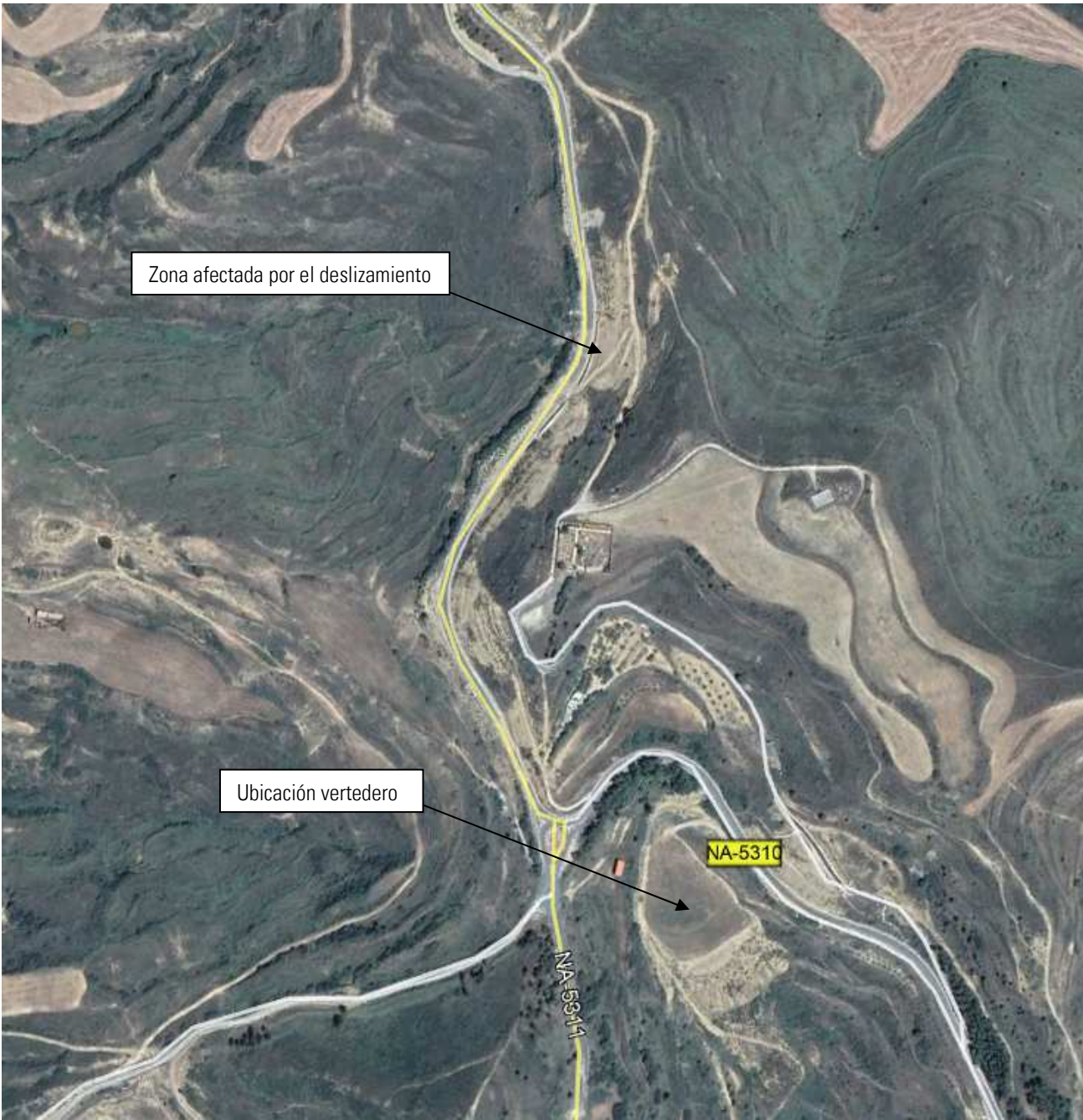
Imagen 1. Se ha marcado la ubicación de la zona en la que se encuentra el deslizamiento, en la cual se ejecutarán las obras y el espacio propuesto como vertedero.
