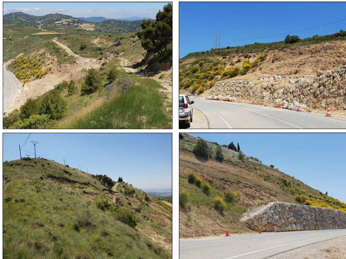
Arriba: Vista general del área deslizada en abril de 2018 desde el camino del cementerio (Izda.) y aspecto del pie del talud con la parte superior de la escollera dañada por el arrastre de la colada de lodo (Dcha.).
