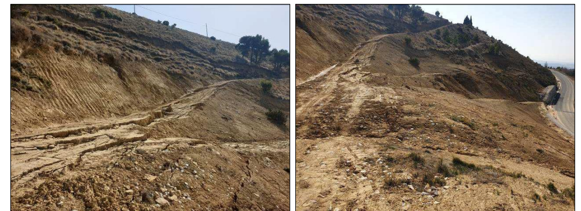
Izquierda: Vista del camino del cementerio en el que se aprecian las grietas y el desplazamiento del terreno producido por las lluvias de febrero.
