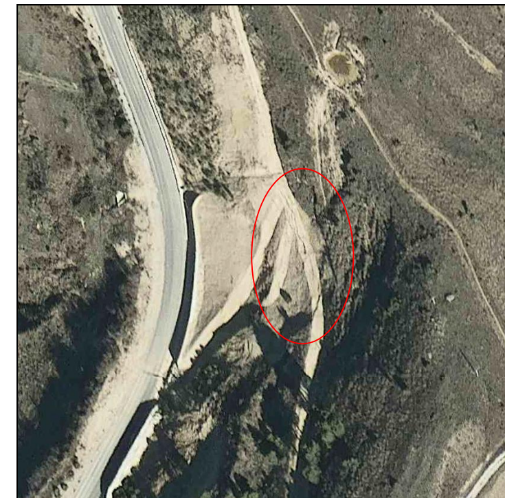
Ortofotografía de 2019 en la que se pueden apreciar las grietas originadas por el movimiento del terreno tras las lluvias de febrero.
