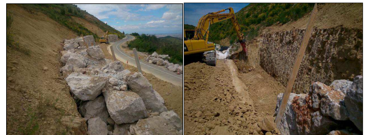
Izquierda: Fotografía del pie del talud tomada el 9/6/2016 durante la construcción de la escollera que actualmente refuerza el pie del talud.
